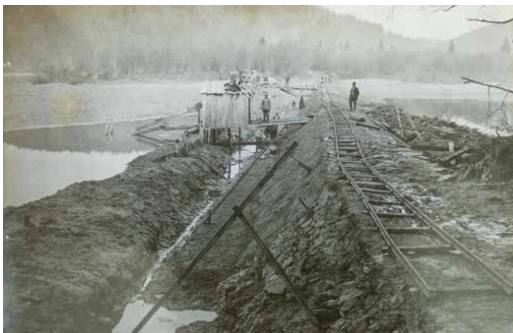
Abb 9: Bauarbeiten am Verbindungsdamm mit Einsatz einer Feldbahn. Im Hintergrund eine große Kiesbank erkennbar (heute K I), die sich in den Seitenarm als Kiesstrand fortsetzte. (Foto: 12.11.1926, STADTWERKE PASSAU 1927).
