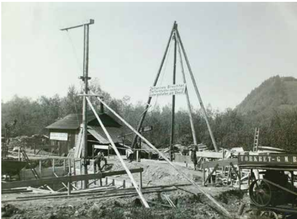
Abb. 1: Bohr- und Bauarbeiten für die Trinkwassergewinnung auf der Soldatenau (Foto: 21.4.1927, STADTWERKE PASSAU 1927).
