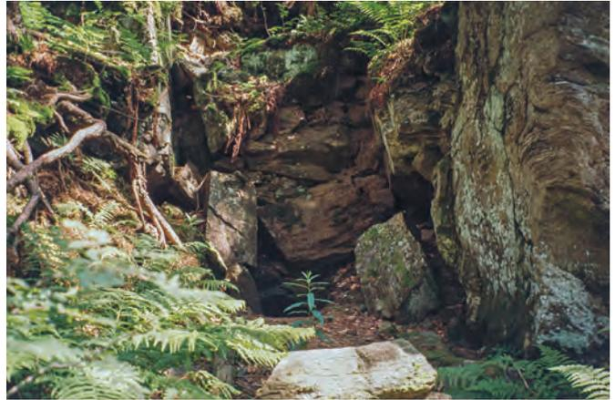
Abb. 8: Eingesacktes Mundloch der hinteren Hirschengrube – Zustand 12.7.2023.
