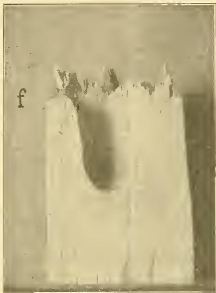
Abb. 2. Längsschnitt der in Abb. 1 dargestellten Kehle. f Ringloch.
