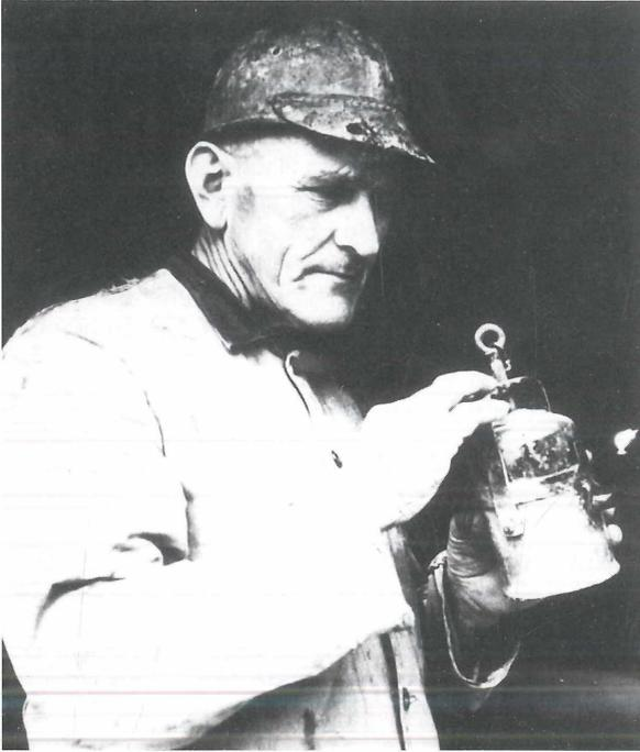
**Abb. 1:** Im Tiefbau „Lengemannschacht“ der AG Vereinigte Großalmeroder Thonwerke im Jahre 1955. Vorarbeiter Otto ENGELMOHR mit seiner Karbidlampe von Hesse / Nürnberg, Typ 111/2, mit Druckbügelverschluss aus Eisen.
