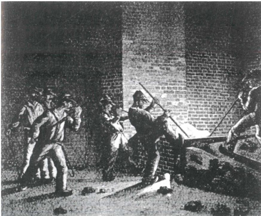
**Abb. 10:** Herausziehen einer schweren Luppe aus einem Stückofen um 1800.
