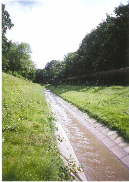
Abb. 5: Noch fließt die Emscher in Betonschalen und stellt eine Ausbreitungsbarriere für Amphibien und andere Tiere sowie den Menschen dar.
