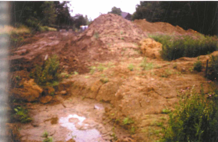
Abb.14: Die Bauarbeiten bei der Kanallegung an der Emscher schaffen vegetationsarme Flächen und temporäre Kleingewässer, die in diesem Stadium optimal für die Kreuzkröte sind, bei intensiven Begrünungsmaßnahmen jedoch zerstört würden.
