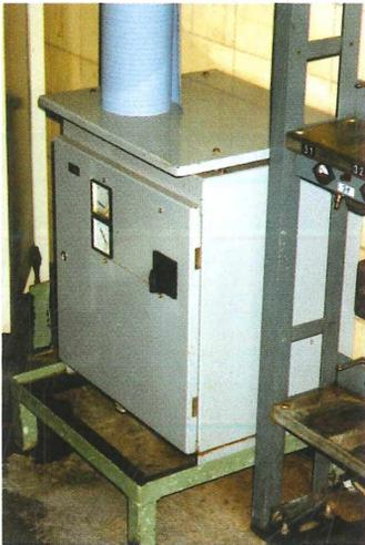
**Abb. 29:** 85 A (?) Gleichrichter in der Lampenstube der Zeche Hirschberg bei Großalmerode.
