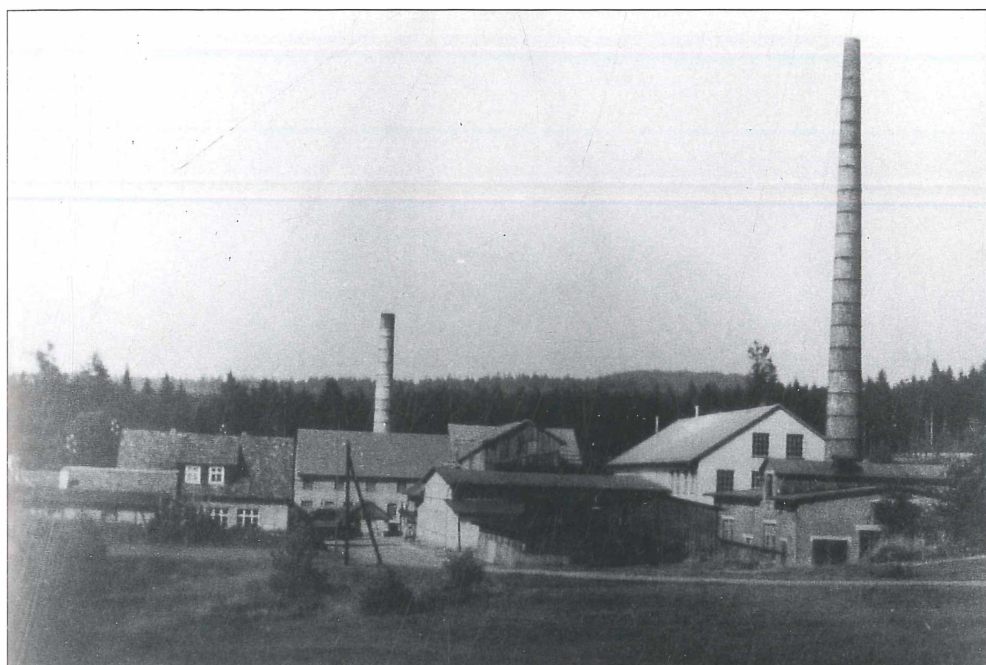
Abb. 11: Schamottefabrik der Gewerkschaft Steinberg & Boolsgraben um 1930. (Foto: Richard VONHOF)
