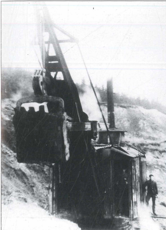
Abb. 7: O&K Dampflöffelbagger vom Typ 8 in der Abraumgewinnung im A-Feld um 1928. (Foto: Georg HILDEBRAND)
