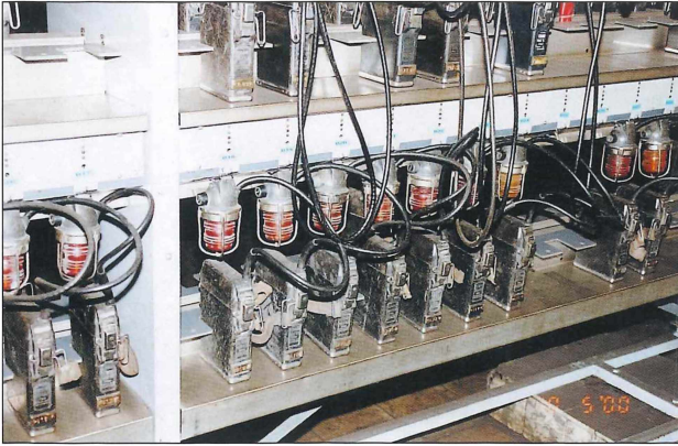
Abb. 5: CEAG Blink-Kopfleuchten vom Typ MLC 9.2 B während einer Ladephase an der Ladebühne. Lampenstube auf dem Verbundbergwerk Lohberg/Osterfeld im Mai 2000. (Foto: Axel URFF)
