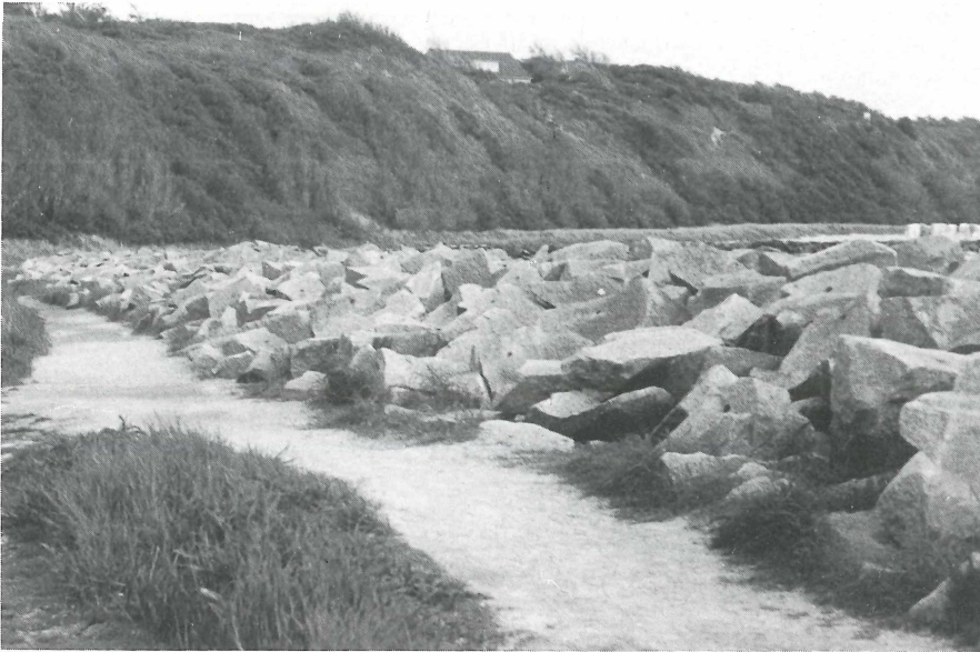
Abb. 2: Blick auf den neuen Steindamm. Die unregelmäßige Ablagerung der Steine verhindert die Entwicklung günstiger mikroklimatischer Verhältnisse.
