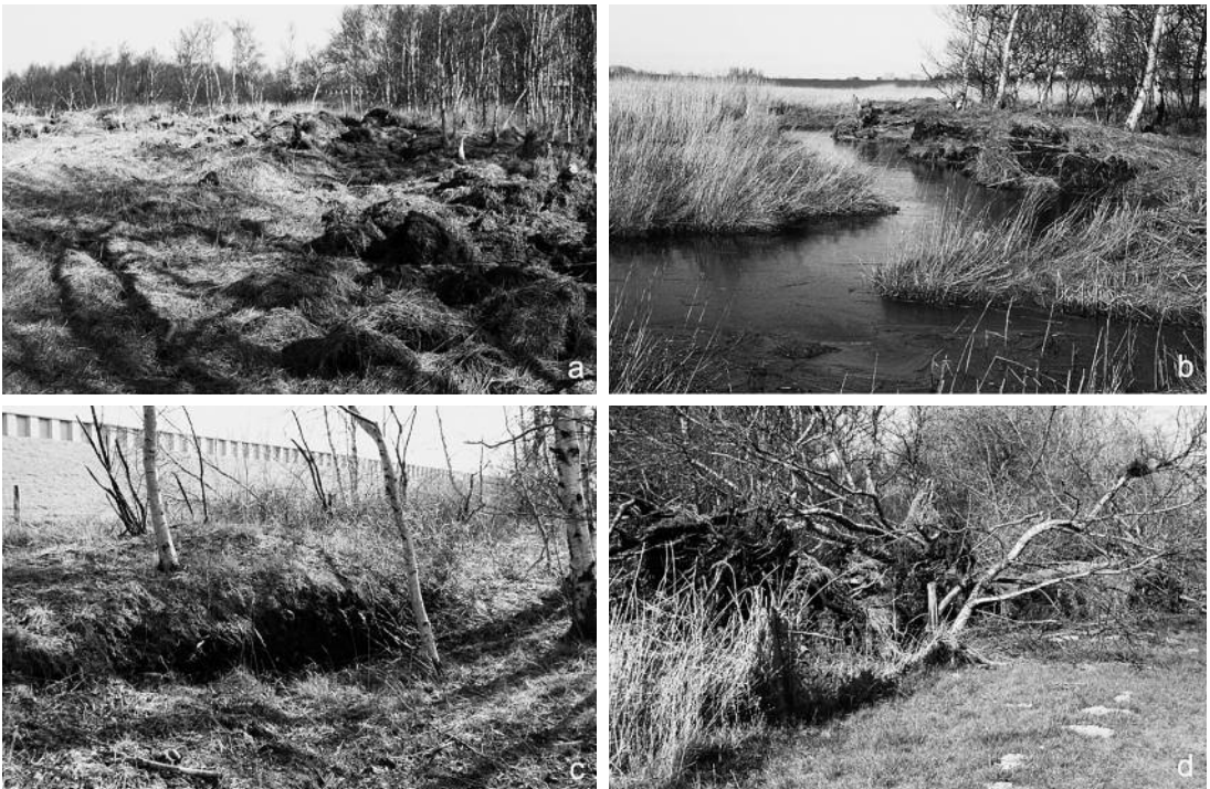
Abb. 4: (a) Zerstörungen am Kliff im nördlichsten Bereich. Aus dem bereits vorher aufgebrochenen Moor wurden Dargen abgetrennt und der Einbruch teilweise mit Schilffresten ausgefüllt. Foto 28.3.07. – (b) Entlang des Kliffs (hier im Nordbereich) entstand durch die Verschiebung eine 1–2 m breite neue Rinne. Foto 20.3.07. – (c) Zum Deich hin (hier im Südbereich) wurde ein 1 m hoher Wall aufgestaut (gesehen von der Moorseite). – (d) Beim Vorschleppen an den Deich wurden vom Moor die dort stehenden Bäume umgestürzt (gesehen von der Deichseite). Beide Fotos 28.3.07.
