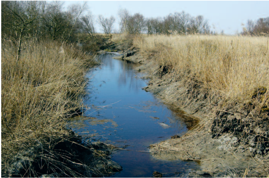
Abb. 1: Die neu entstandene Rinne zwischen dem zentralen und dem südlichen Moorteil. Foto 28.3.07 vom Deich.
