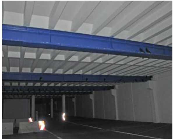
Abb. 2: Die Alpendohlen schlafen auf vier Metallträgern verteilt. Foto: S. Bosch. Fig. 2: The Alpine Choughs are roosting on four double-T-girders.
