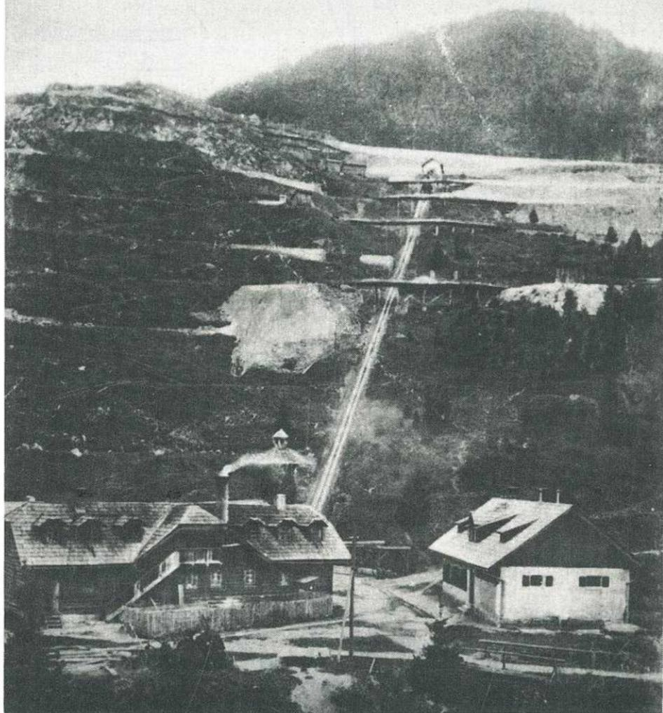
Der Tagbau des Magnesitbergbaues Sunk bei Trieben mit dem Schrägaufzug ca. um 1911.
