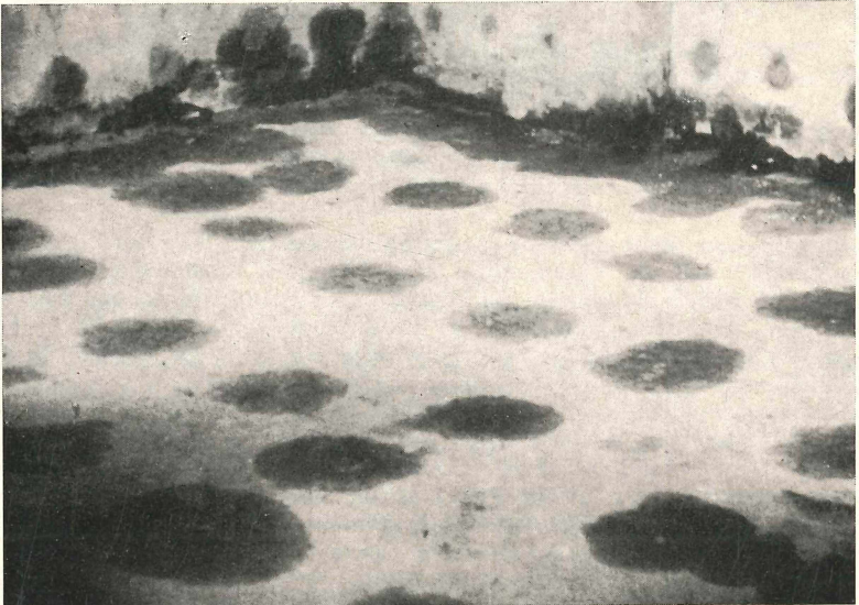
Impfungen im Mauerwerk und im betonierten Boden mit „Avenarol TM“. Die Flecken sind nach 12 Stunden verschwunden.
