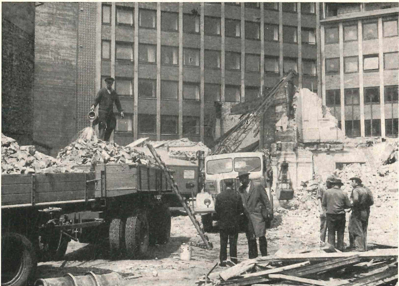
Hamburg-Innenstadt. Termitenverdächtiger Abbruchschutt wird mit einer Bekämpfungs-Emulsion besprüht. Hinten neue Bürohäuser an Stelle der alten Fachwerkbauten.
