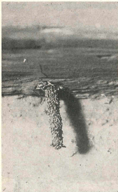
Röhre, die aus einem unverputzten Balken herausgebaut wird.
