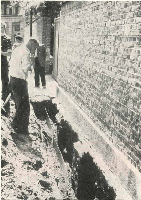
Der Sperrgraben wird wieder gefüllt. Das Erdreich ist mit „Termiten-Avenarol dunkel“ vermischt worden.
