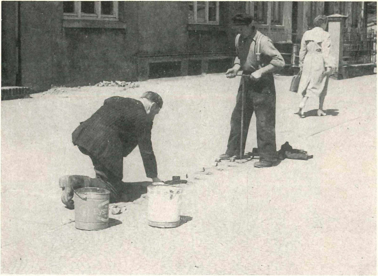
Bohrlochimpfung mit Termiten-Gas.
