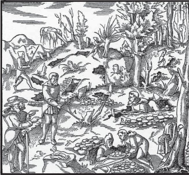
Abb. 1: Aufsuchen von Erzgängen mit Wünschelruten und durch Schürfgräben (aus GEORG AGRICOLA 1556).
