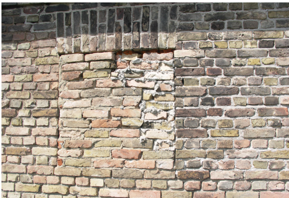
Abb. 7. Vor allem im Bereich der zugemauerten Fenster gibt es viele Fugen und Löcher, die von Hoplitis adunca , Megachile pilidens und anderen Bienenarten als Nistplatz genutzt werden. Foto: C. Saure, 14. Juli 2020.
