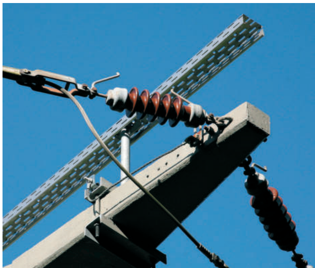
Abb. 6: Untauglich: Sitzprofil mit leitfähiger Befestigung
