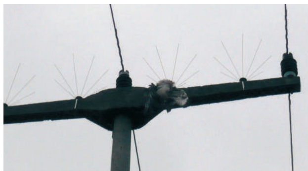
Abb. 11: Die Montage von Büschelabweisern statt Abdeckhauben kann wie hier im Bild fatale Folgen haben. Zwischen Büschelabweiser und Stromquelle traf den Bussard der Schlag. Der Vogel ist dann im Büschelabweiser hängen geblieben.
