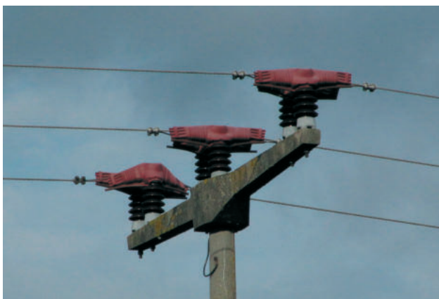
Abb. 2: Untauglich: Verkürzte Abdeckhauben. Hauben müssen mind. 130 cm lang sein.
