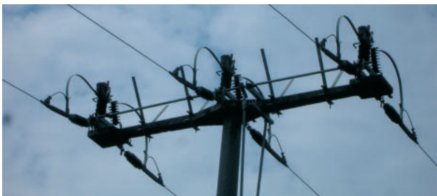
Abb. 4: Untauglich: V-förmige Vogelabweiser (hier zwischen den Schalterelementen)
