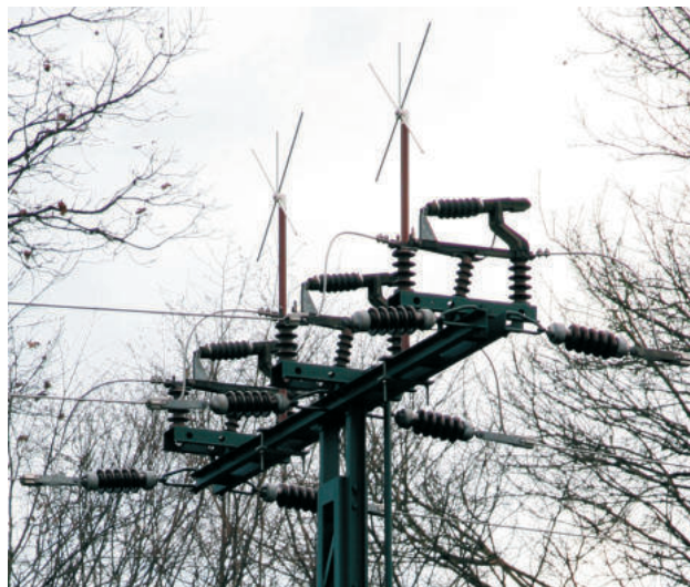
Abb. 7: Masten mit Schalter auf dem Mastkopf dürfen nicht mehr errichtet werden. Bei alten Masten dieses Typs sind Andreaskreuze (hier im Mastschalter) zulässig.
