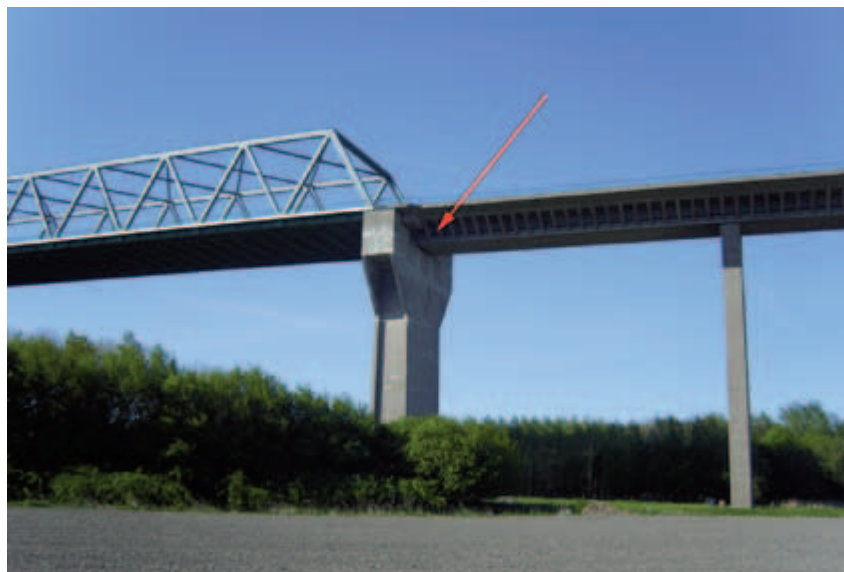
Abbildung 1: 30.4.2011, Teilansicht der Hochbrücke bei Brunsbüttel. Der rote Pfeil weist auf den Uhubrutplatz
