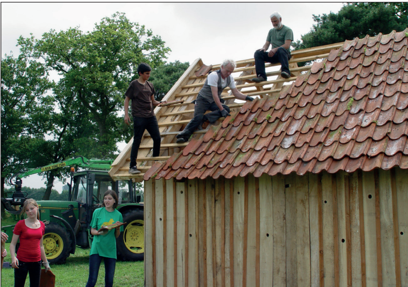
Abbildung 15: Bau einer neuen Viehhütte, Sommer 2013
