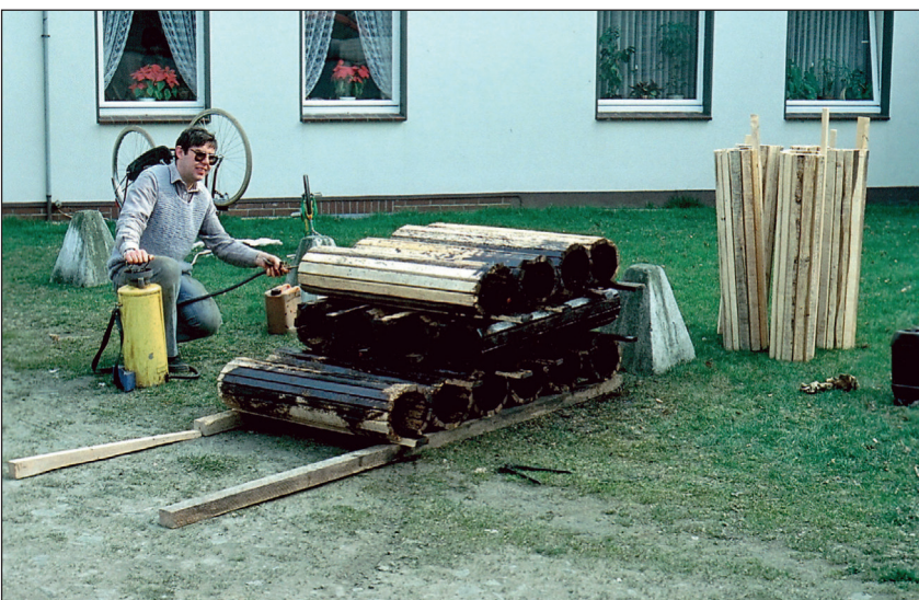
Abbildung 5: Bau von „mardersicheren“ Röhren, 1970er Jahre
