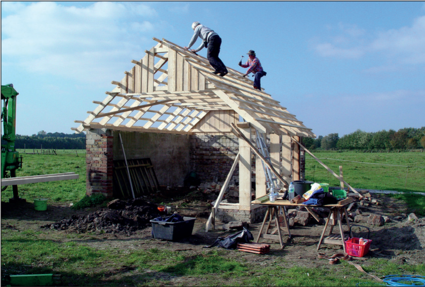
Abbildung 14: Ab 2009 begann die Reparatur der ersten Hütte, Aufnahme von 2010
