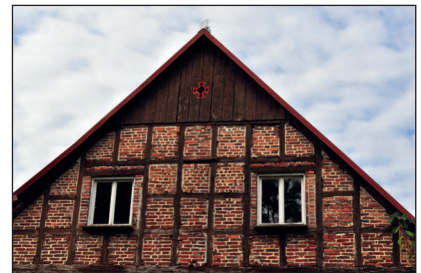
Abb. 8: Sundern-Amecke, Illingheimer Straße 21 (Baujahr 1876) (Foto: L. SCHULTE-ILLINGHEIM)
