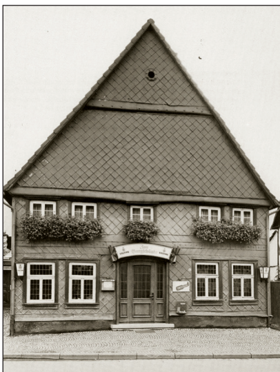
Abb. 5: Giebelverkleidung Burgschänke, Hachen mit Formblechen, (Baujahr 2. Hälfte 18. Jahrhundert) (Foto F. ACKERMANN, 1985)
