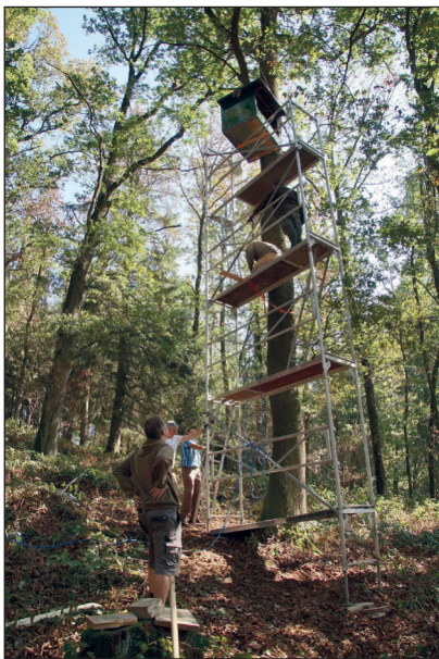
Abbildung 2: Brutkasten für den Uhu (Bodenmaße 100 cm x 80 cm, Höhe 80 cm auf der Baumseite und 65 cm gegenüber) aus Betonplanplatten 4 mm. Wichtig ist innen eine ausreichende Versteifung mit Dachlatten (Foto: STEFAN RIEDL)
