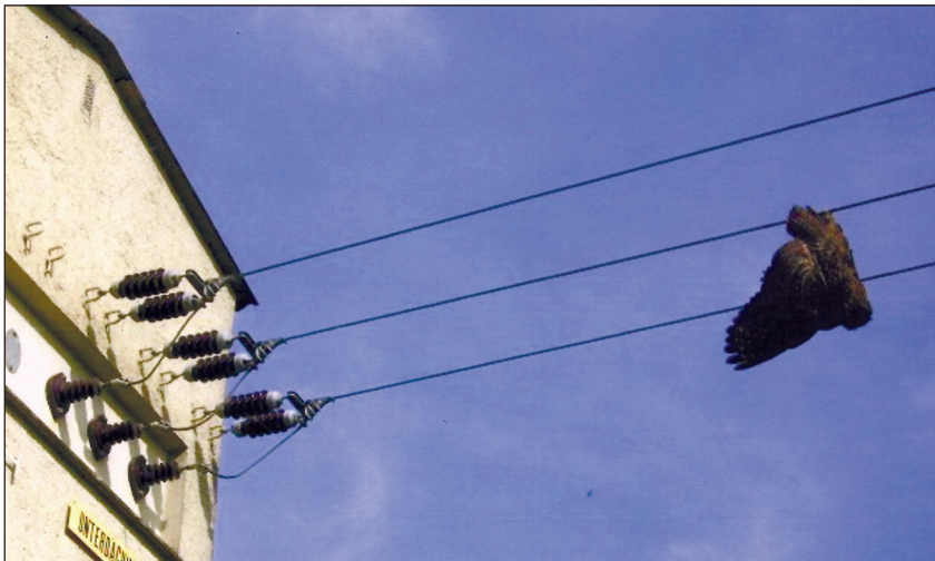
Abbildung 5: Transformatorenstationen als Gefahrenquelle für Uhus und Greifvögel (Foto: DIETER AICHNER)
