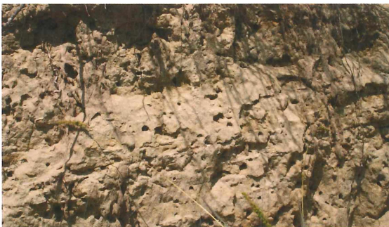
Abb. 6: Niströhren in der Abbruch- kante 2009 (Foto: Klaus Mandery)
