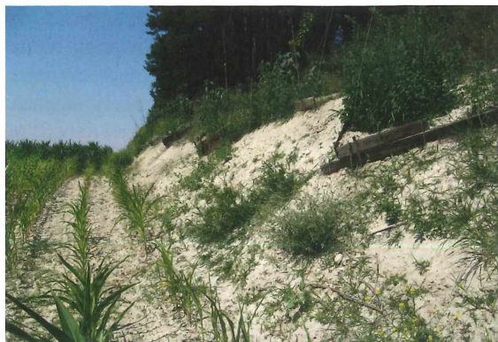
Abb. 7: Durch den Landwirt „sanierte“ Abbruchkante am ursprünglichen Nistplatz (Foto: Klaus Mandery)
