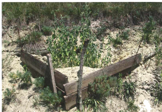
Abb. 8: Verbauung und Verschüttung der Abbruchkante (Foto: Klaus Mandery)
