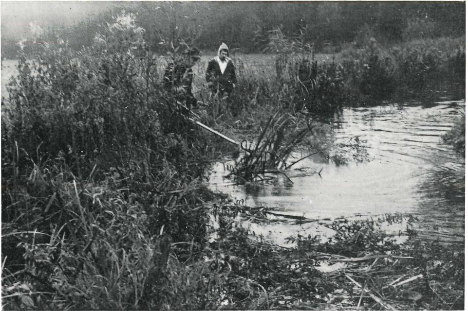
Abb. 2. Mähen der Makrophyten mit einem schneidenden Propeller im Unteren Schierensee-
