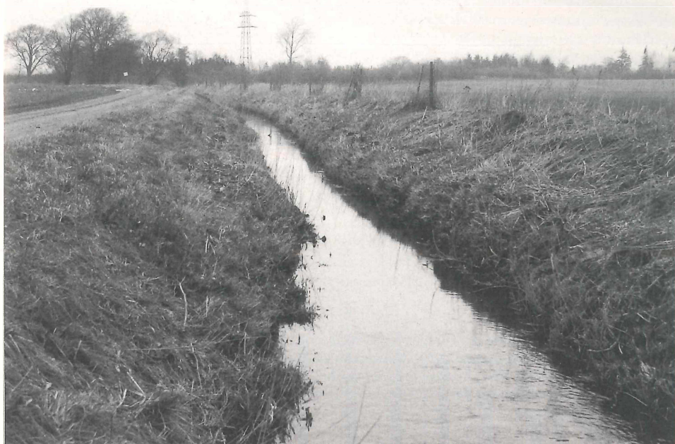
Abb. 3: Farver Au mit der Probestelle FA2. Der Bach ist an dieser Stelle begradigt, sohlvertieft und die Gehölze sind entfernt. Breite des Bachbetts nahezu einheitlich 2 m. Blick bachabwärts (Aufnahme P. MARTIN, März 1993).
