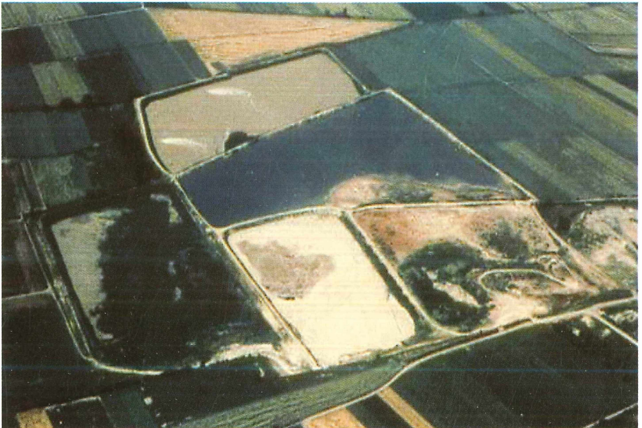
Abb. 3: Luftaufnahme der Klärteiche der Zuckerfabrik Offstein aus südlicher Richtung (Stand: 1977). Foto: SÜDZUCKER OFFSTEIN.
