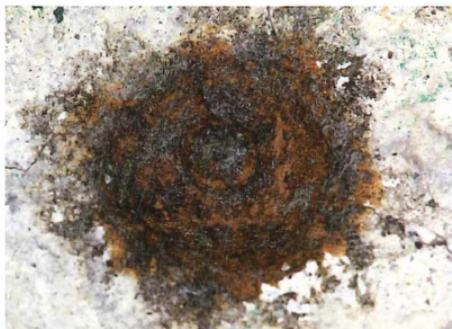
Abb. 12: Gießblase von Betonsockel, Worms/„Bürgerweide“, 5. Dezember 2013 (vgl. Abb. 1 und 2). Fotos: G. REDER.
