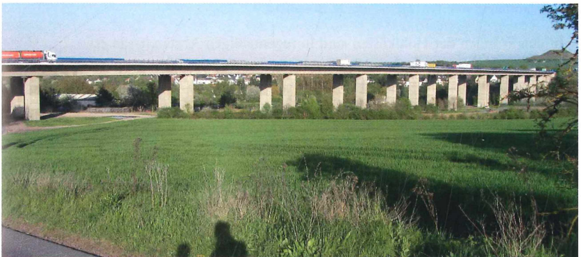
Abb. 1: Ansicht der untersuchten Brücke aus nordwestlicher Richtung mit Umgebung. Foto: N. BUCHHOLZ.
