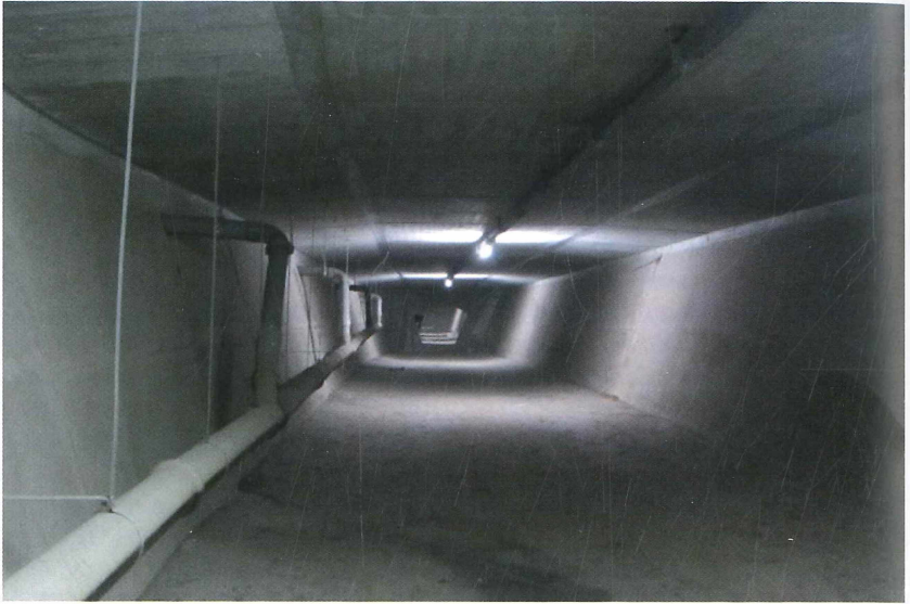
Abb. 2: Blick in einen Brückenhohlkasten, den man auf ganzer Länge durchgehen kann, links (Ostseite der Brücke) mit Regenwasserableitung ins Innere, unter dem Rohrdurchbruch (RR) ist eine Rohröffnung, Typ „L“ sichtbar, auf der gegenüberliegenden Seite im Lichtkegel am oberen Rand eine Rohröffnung vom Typ „OL“. Foto: N. BUCHHOLZ.
