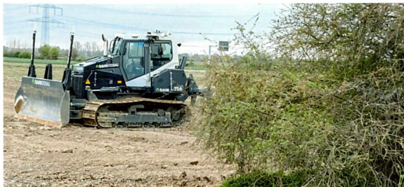
Abb. 3: Planierdraupe zur Verteilung eingebrachter Erdmassen am Wormser Loch. Foto: Kurt BELZER.
