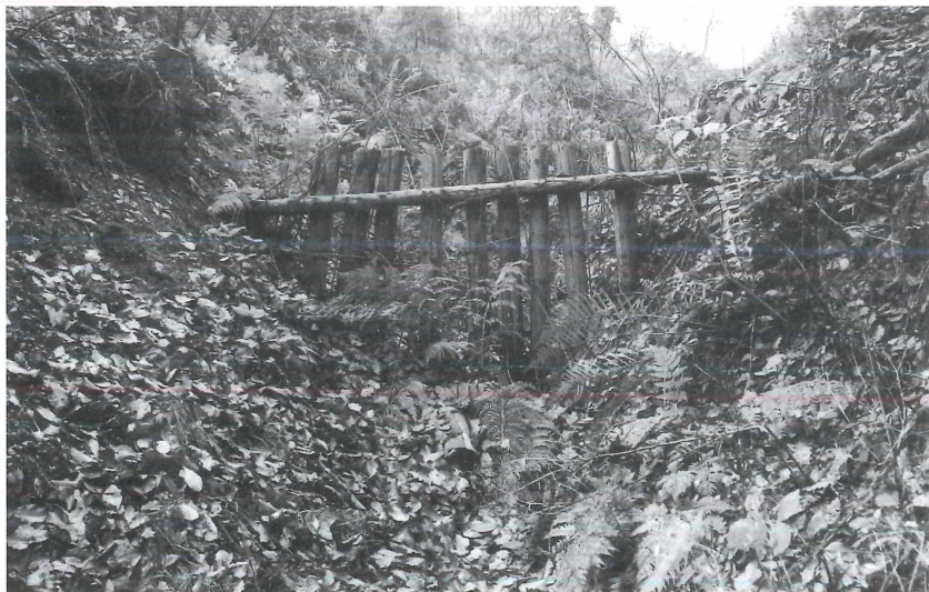
Abb. 10: Palisadenwand im Grabenabschnitt B nach Fertigstellung. Oktober 1999, Foto: N. KLEIN
