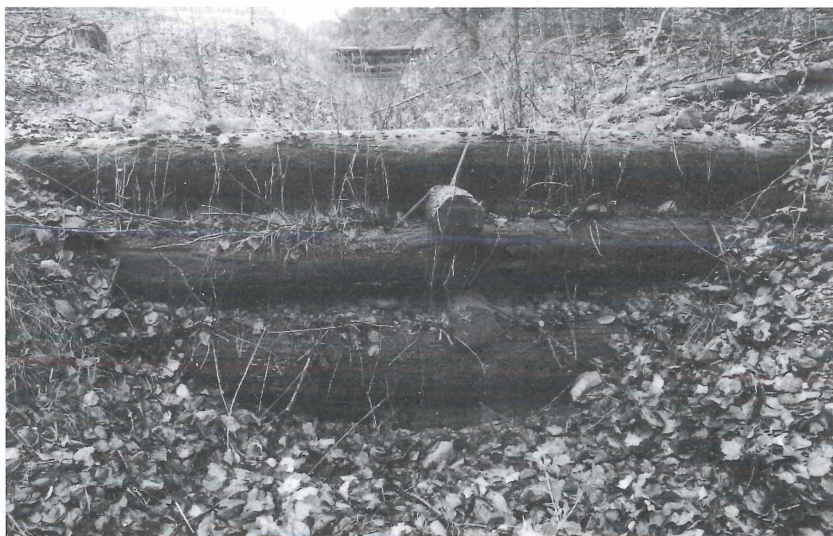
Abb. 8: Die Holzkrainerwand in Grabenabschnitt B. Vorderansicht. Oktober 1999, Foto: N. KLEIN
