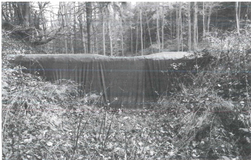
Abb. 12: In herkömmlicher Bauweise erstellte Holzschwellenwand aus Eiche mit Teichfolie in Grabenabschnitt B. Oktober 1999, Foto: N. KLEIN
