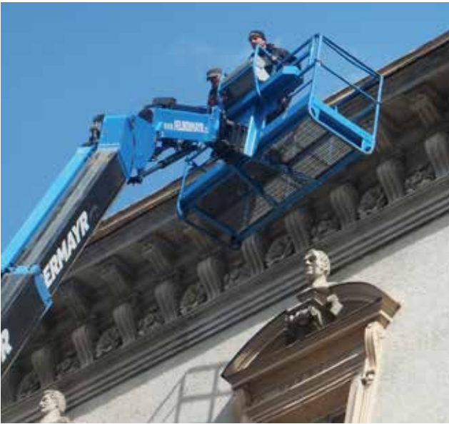
Die Restaurierung erfordert zentimetergenaues Manövrieren der Hubsteiger. Foto: TLMF/Telser
