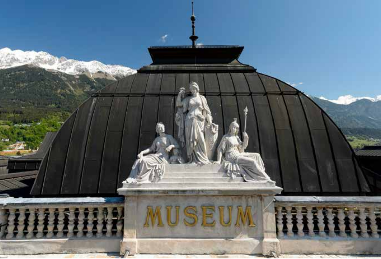
Die Tyrolia erhält eine neue Bleiverblechung. Foto: TLMF/Lackner
