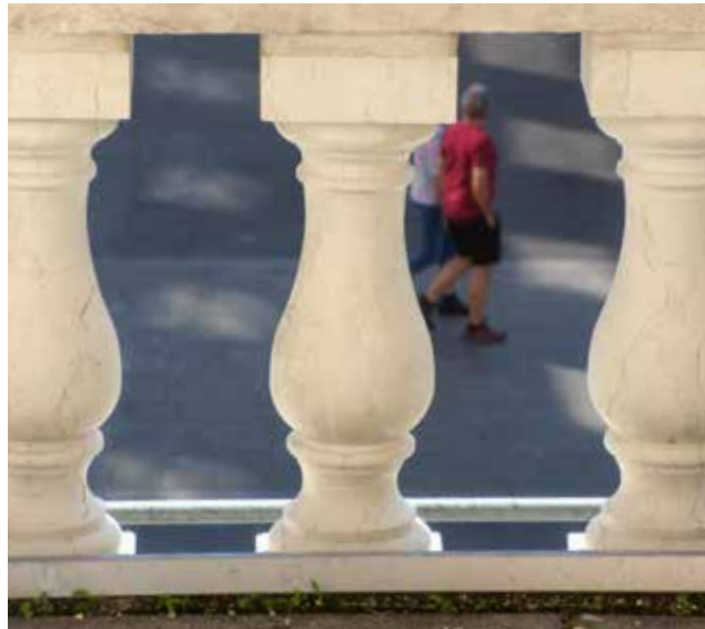
2013 erneuerte Säulen der Balkonbalustrade, gesehen vom „Historischen Gang“ im 1. Obergeschoß. Foto: Hastaba
