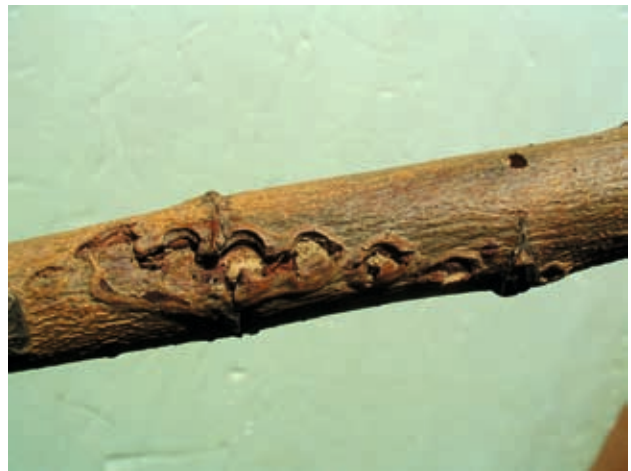
c: Schadbilder Larvenfraß Zentralgang und Lüftungslöcher
