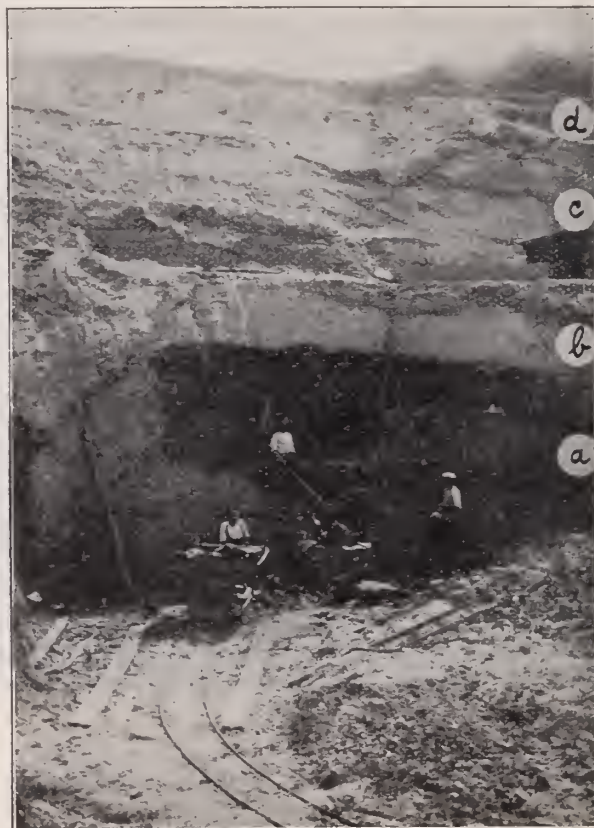
Abb. 9. Der Osterfelder Flammenton. a) Flammenton. b) Weißer Ton. c) Tertiärer Kies und Sand. d) Diluvium.
