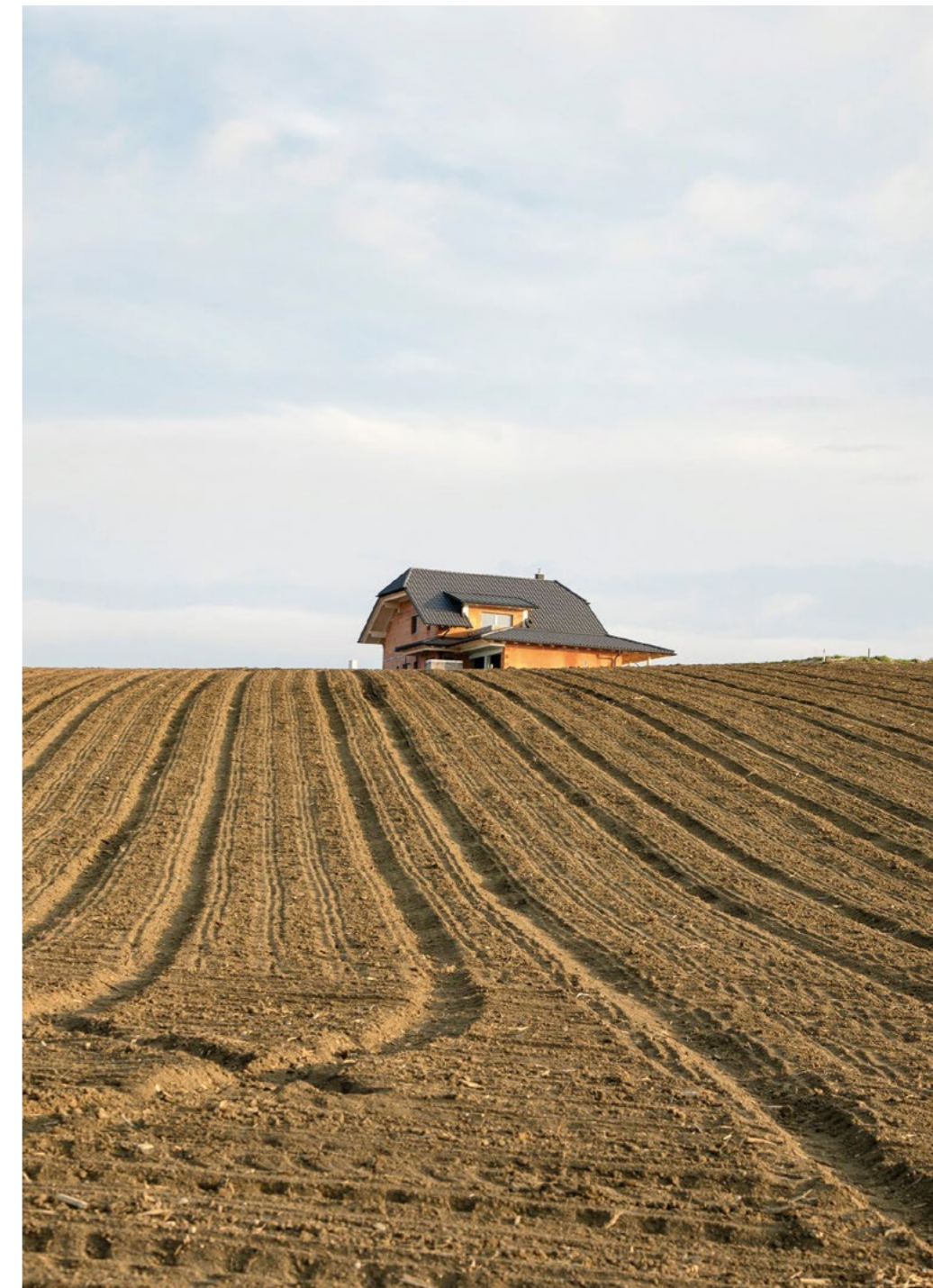
▼ Rohbau eines Einfamilienhauses auf Acker, Scharthen Foto: Paul Kranzler & Andrew Phelps
