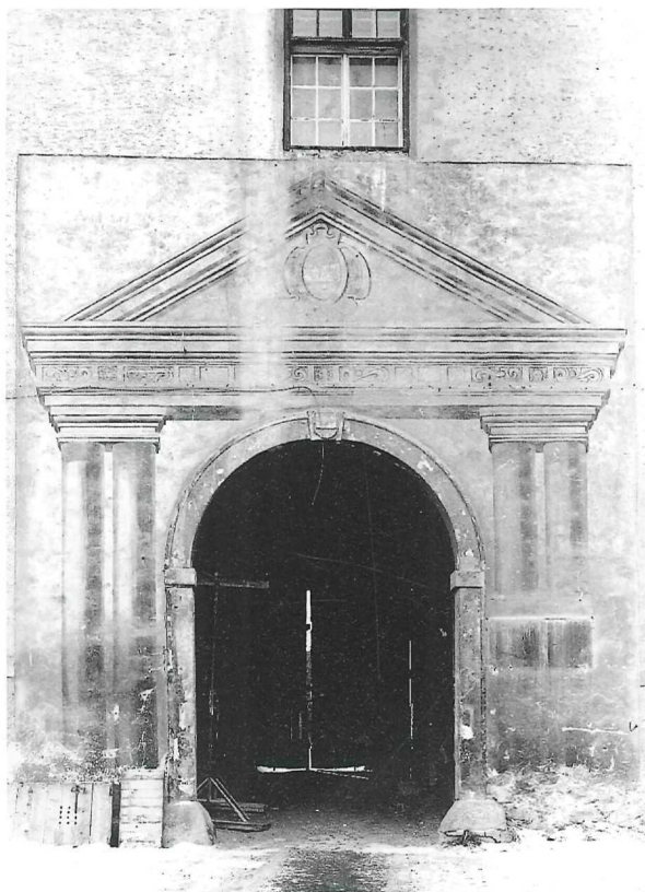
Architekturmalerei auf dem Tor des Westtraktes Bauzustand von 1959
