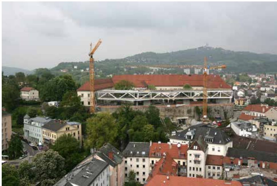
ABB. 38: Schlossmuseum Linz, Bauzustand im Mai 2008
