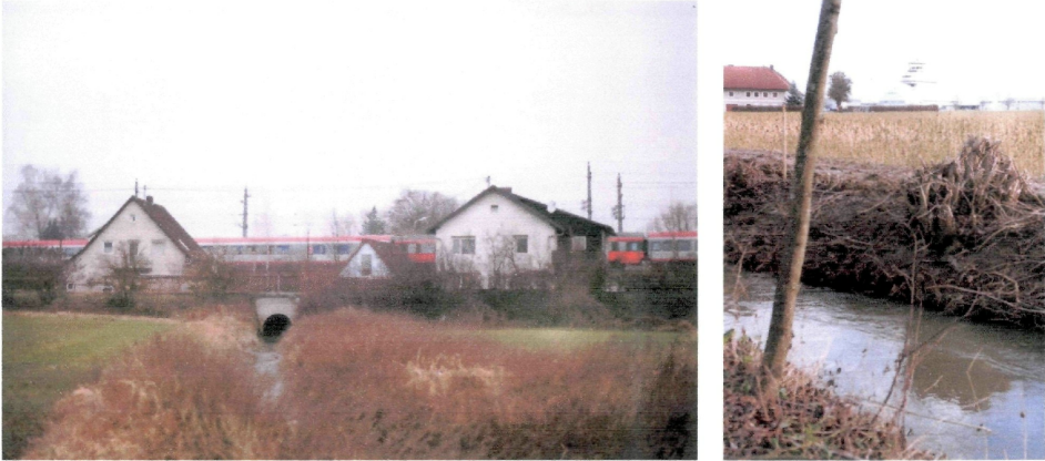
Abb. 41: Südlich von Breitbrunn fließt der Grundbach verrohrt unter Straße und Westbahn durch.
