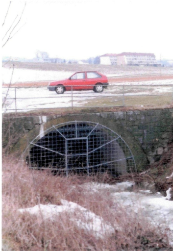
Abb. 60: Hier verschwindet der Grundbach endgültig im Kanalsystem.
