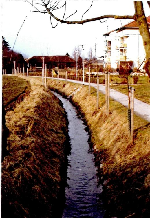
*Abb. 17: Mit V-Profil und gepflasterter Sohle wird der Krumbach im Ortsgebiet von Pasching als unnatürlicher Kanal geführt.*
