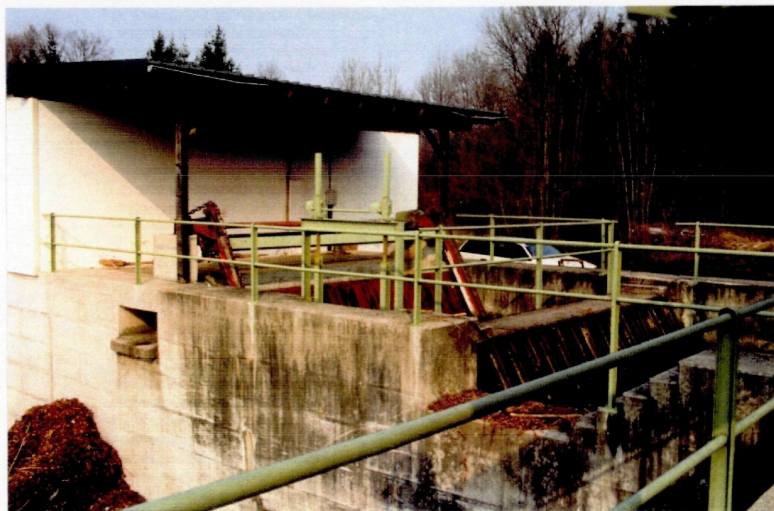
Abb. 131: Rechen- und Einlaufbauwerk der Wasserkraftanlage Stegmühlwehr
