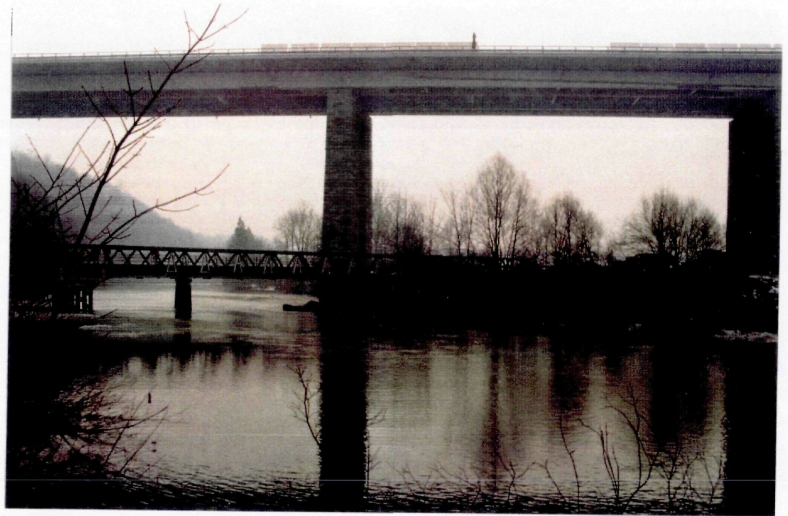
Abb. 123: Die aufgestaute Alm oberhalb dem Mühltalerwehr
