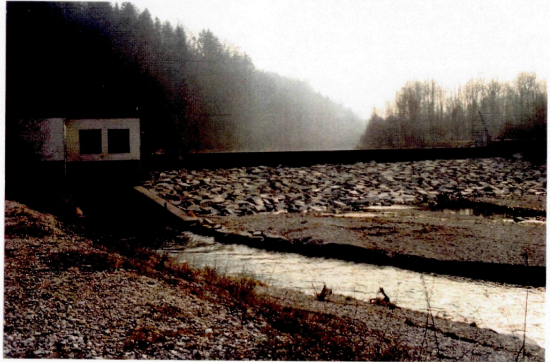
Abb. 132: Der Unterwasserkanal mündet unmittelbar unterhalb der Sohlrampe rechts in den Almfluß
