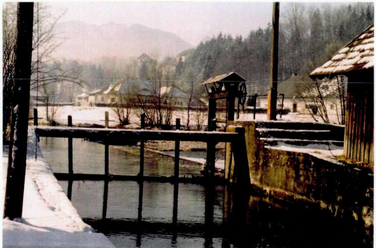
Abb. 52: Ausleitungsstelle des Mühlbaches der Niedersäge
