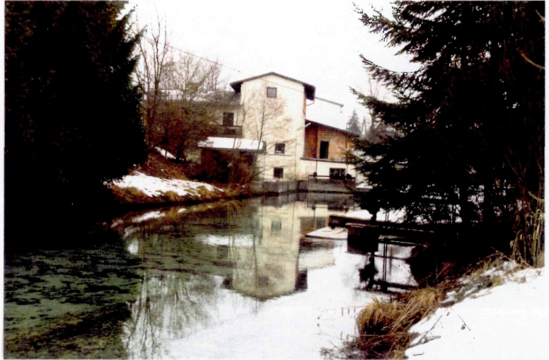
Abb. 73: Das Einlaufbauwerk der Bruckmühle
