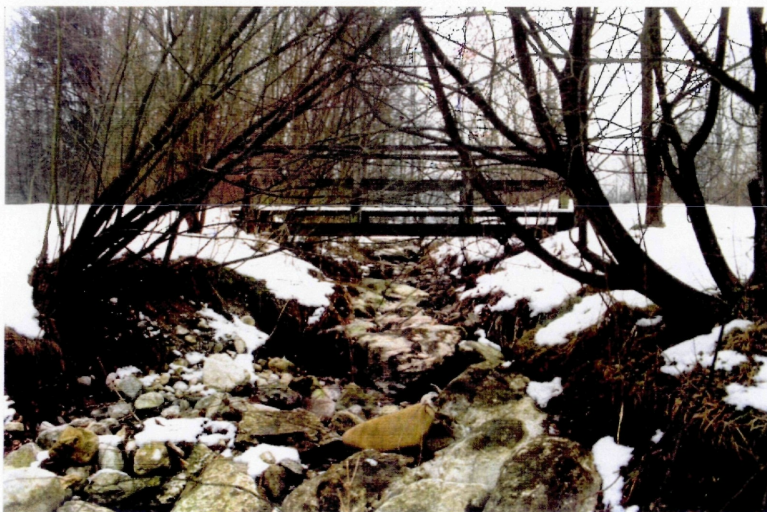
Abb. 93: Das durch ein Hochwasserereignis beschädigte und trockengefallene Fischaufstiegsgerinne
