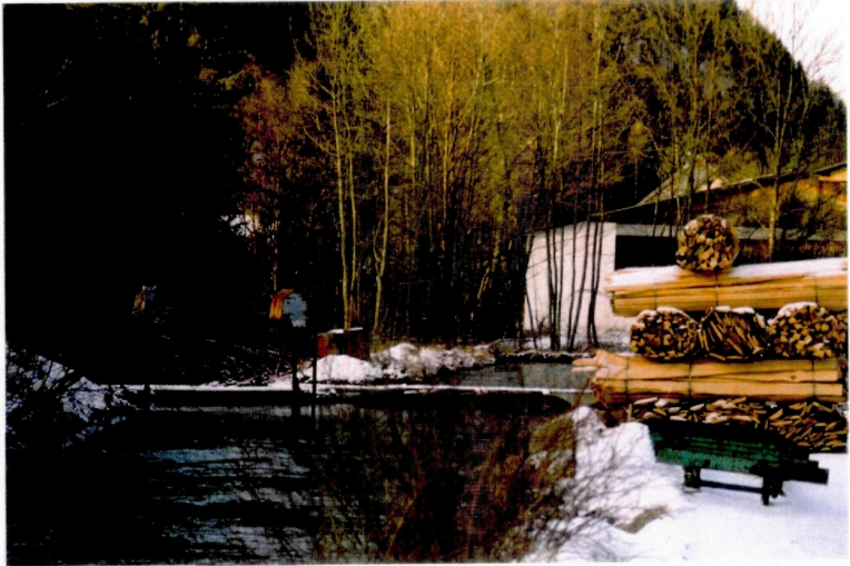
Abb. 16: Zuleitung zum Krafthaus der Rabenauersäge
