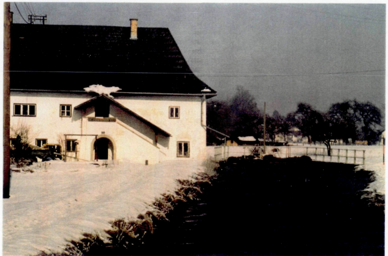
Abb. 58: Ab diesem Bereich wird der Mühlbach über eine 160 m lange Druckrohrleitung zur Viktoriahütte geleitet
