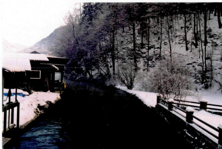
Abb. 33: Der ca. 6 m breite Mühlbach weist ein Kastenprofil in Erdbauweise auf
