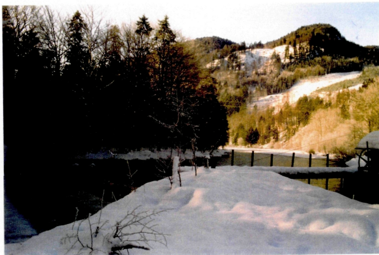
Abb. 9: Das Auingerwehr und der Mühlbach in Richtung flußaufwärts.
