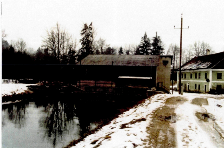
Abb. 102: Einlauf- und Rechenbauwerk der Schwarzmühle
