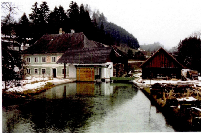
Abb. 71: Die Stoiberauersäge - Rechenbauwerk und Einlauf
