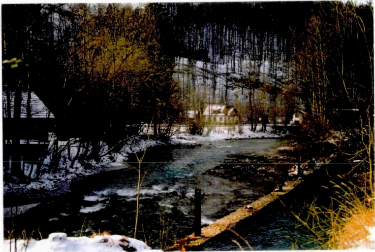
Abb. 17: Der Mühlbach wird auf höherem Geländeniveau noch 386 m weiter zum E-Werk Rabenbrunn geleitet.
