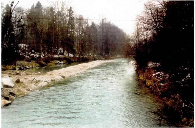
Abb. 96: Das Bett der Alm ist durch einen Schotterdamm vom Unterwasserkanal des E-Werkes Steinbachbrücke getrennt
