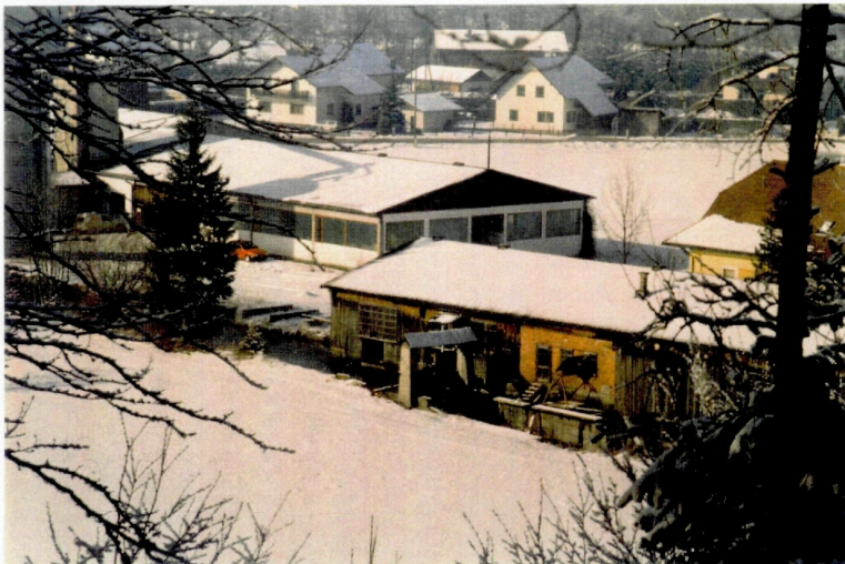
Abb. 65: Blick von der Voralpenstraße auf die Schiffsäge
