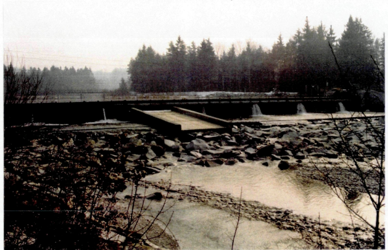
Abb. 128: Blick alaufwärts auf die Wehranlage
