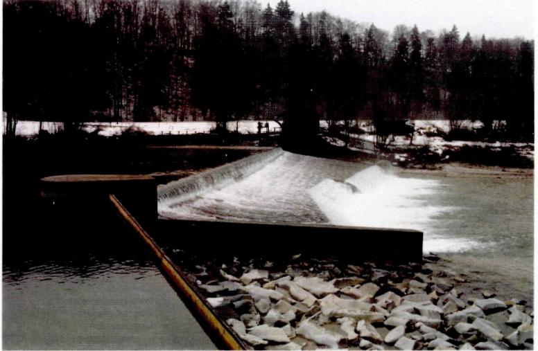
Abb. 89: Die mit Granitblöcken befestigte Wehranlage
