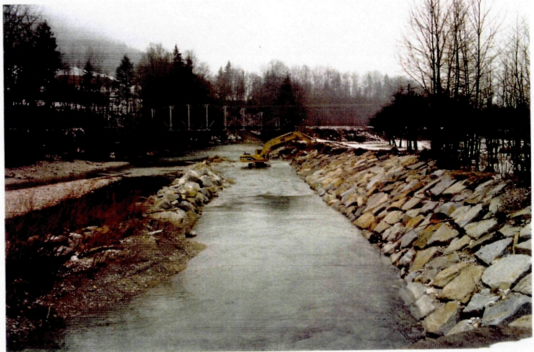
Abb. 87: Die durch Granitblöcke gesicherten Uferböschungen am rechten Ufer des Unterwasserkanales
