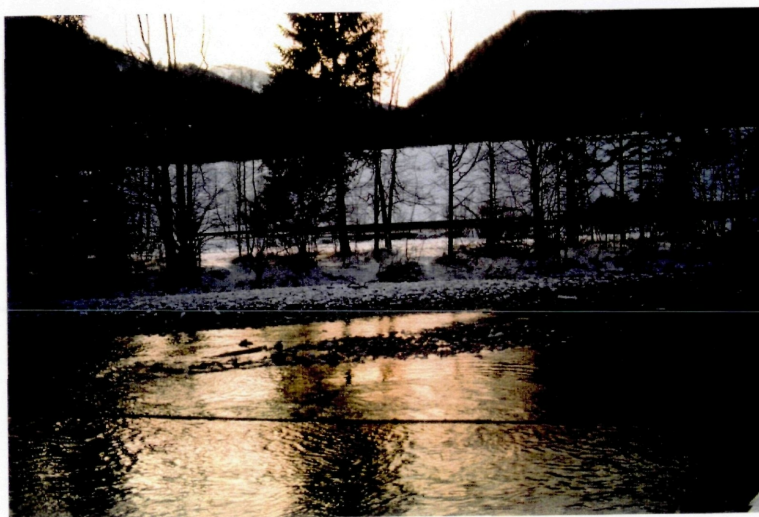
Abb.: 15: Das breite Flußbett der Alm unterhalb der Wehranlage
