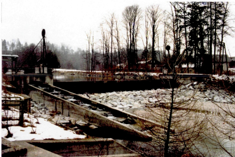
Abb. 86: Rechts an den beidseits von betonierten Wänden flankierten Fischaufstieg schließt sich der kurze Unterwasserkanal der Sperlsäge
