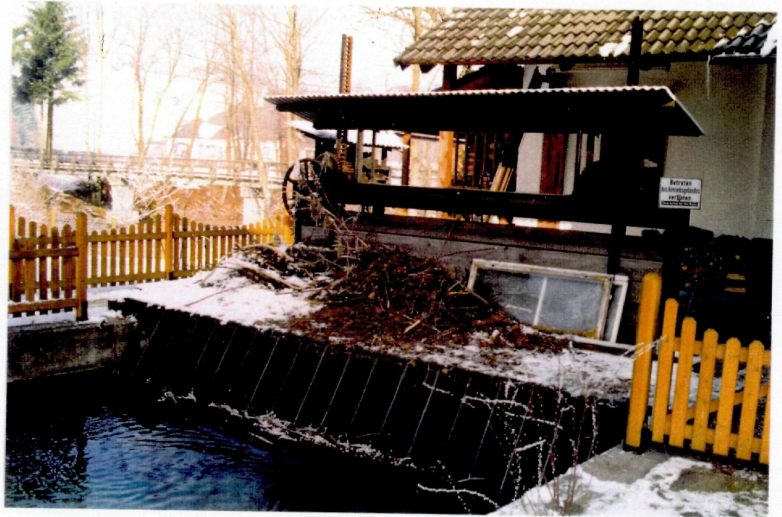
Abb. 53: Rechenanlage und Kraftwerkseinlauf der Niedersäge
