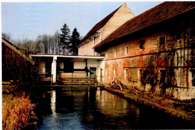
Abb. 134: Rechen- und Einlaufbauwerk der Kranabethmühle
