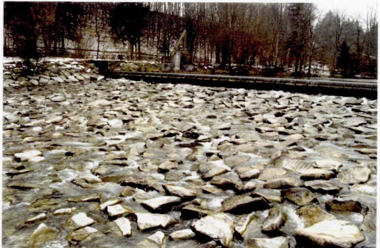
Abb. 104: Sicherung der Wehranlage durch Granitsteinwurf
