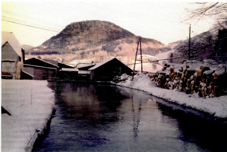
Abb. 34: Blick auf das Rechenbauwerk und das Krafthaus der Rappersäge
