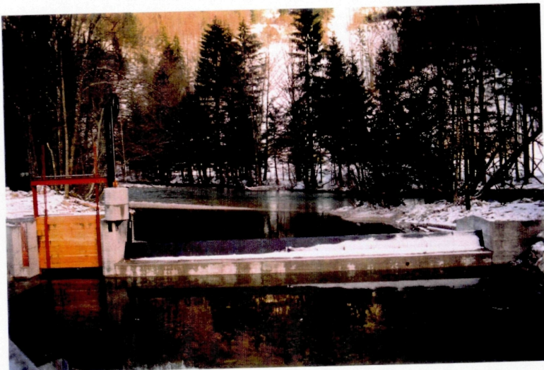
Abb. 23: Diese 2. Wehranlage, die unterhalb der Wehranlage von Abb. 22 liegt, bildet die Ausleitungsstelle des Oberwasserkanales der Rinnbachsäge.
