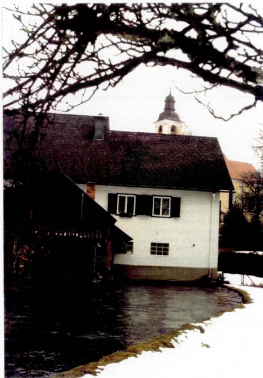
Abb. 35: Einlauf des Mühlbaches in das Krafthaus des E-Werkes I. Die Ufer- böschungen wurden aus Beton aufgebaut
