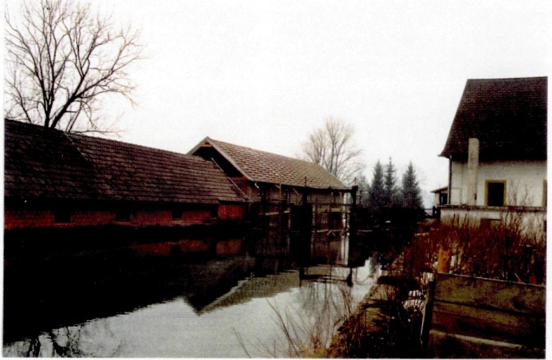
Abb. 116: Einlaufbauwerk der Reichlmühle
