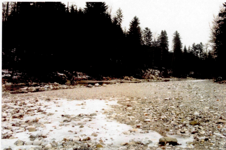
Abb. 101: Im aufgeweiteten Flußbett der Alm sind einige Steinbühnen zur Prallhangsicherung eingebaut
