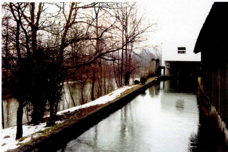
Abb. 107: Einlauf- und Rechenbauwerk der Aizetmühle
