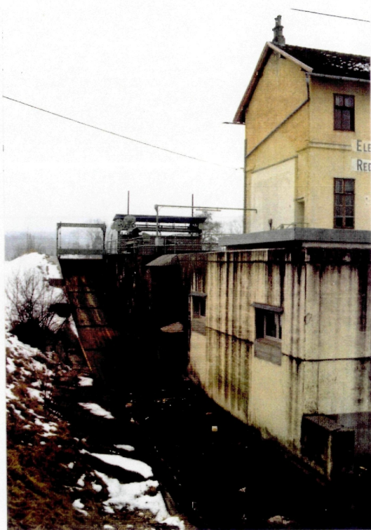
Abb. 99: Friedlmühle - über diese Holzbohlen wird das Rechengut in ein Sammelbecken abgeführt
