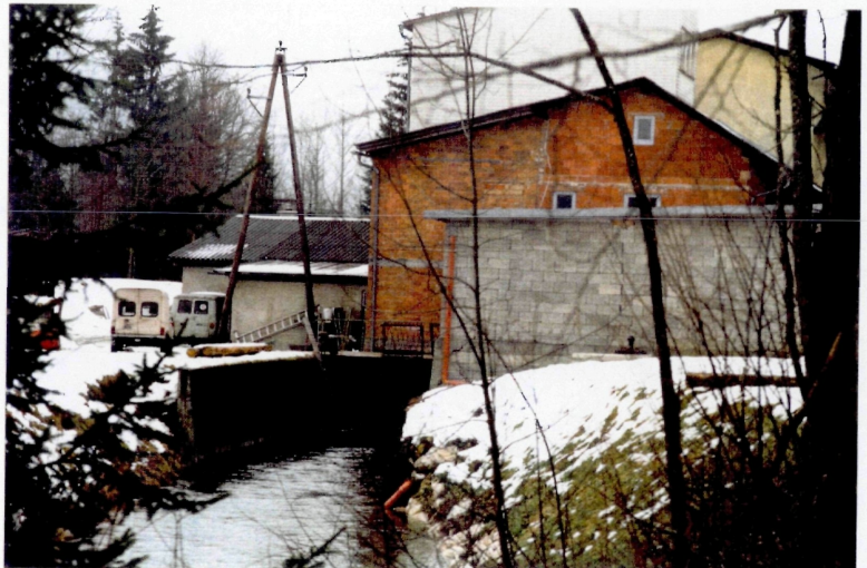
Abb. 74. Unterhalb des Krafthauses sind die Uferböschungen durch Steinwurf im unteren Bereich befestigt
