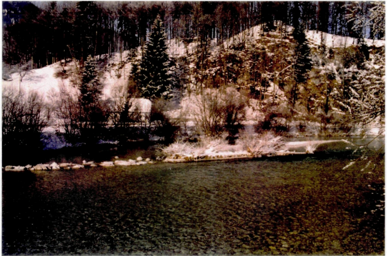
Abb. 30: Oberhalb des Pegels Grünau ist das Flußbett der Alm stark aufgeweitet. In der Gewässermittle konnte eine Insel anlanden, links davon bestehen hölzerne Einbauten.
