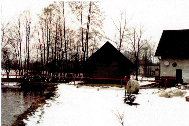
Abb. 97: An einem weiteren, rechts der Alm führenden Mühlbach befindet sich die Wasserkraftanlage der Fa. Zehetner
