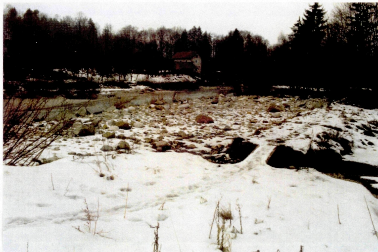
Abb. 94: Einleitungsstelle des Fischeaufstiegsgerinnes
