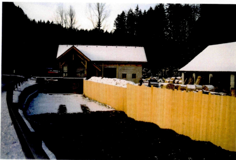
Abb. 25: Der Einlauf zum neu errichteten Krafthaus
