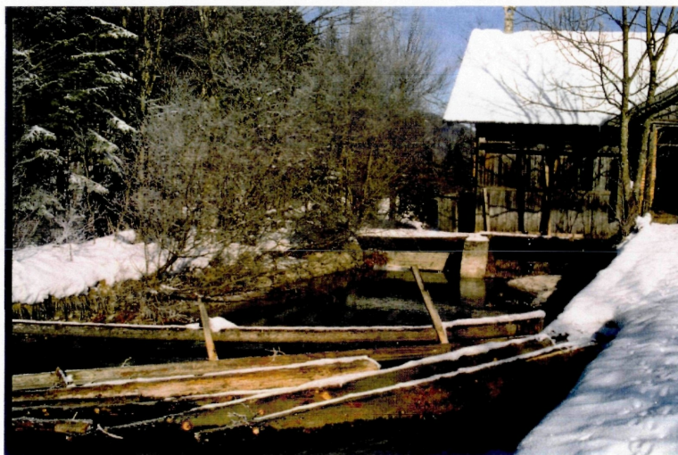
Abb. 12: Einlauf in eine kleine Wasserkraftanlage unterhalb der Auingersäge
