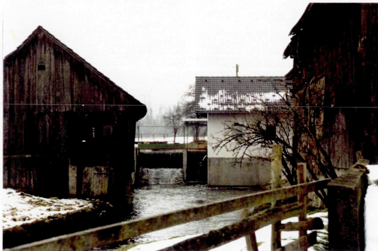
Abb. 72: Die Stoiberauersäge unterwasserseitig
