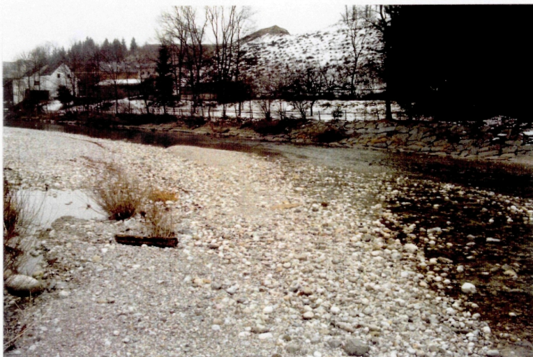
Abb. 105: Das rechte Almufer ist unterhalb der Wehranlage ebenfalls mit Granitsteinen gesichert
