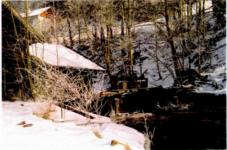
Abb. 44: Rechenanlage der Gangljodlmühle
