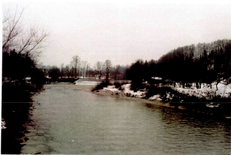
Abb. 88: Blick vom Steg über die Alm zum Brandstattwehr
