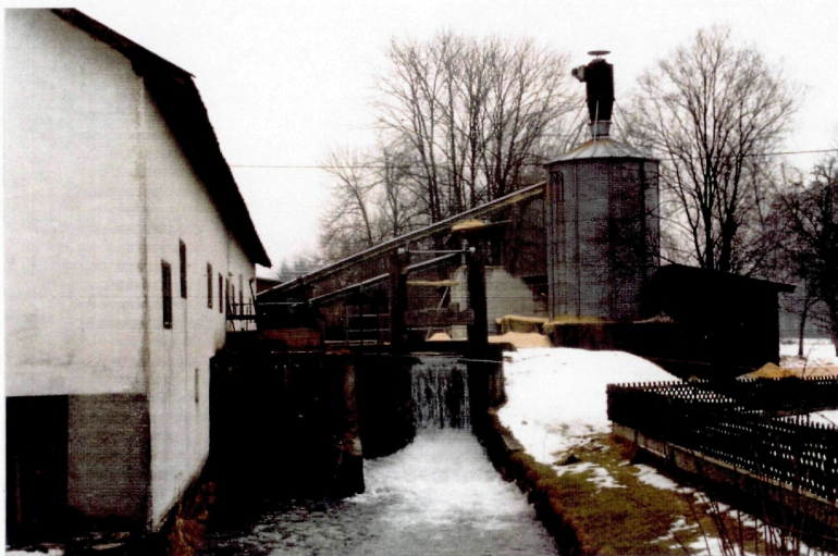
Abb. 112: Überschußgerinne und Auslaufbauwerk der Sattelmühle
