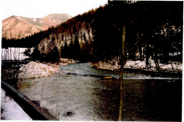
Abb. 28: Almbwärts des Rinnbachwehres sind am linken Ufer Holz- bzw. Steinbuhnen aus Kalksteinen eingebaut worden.
