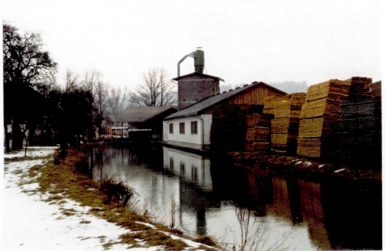
Abb. 108: Rechen- und Einlaufbauwerk der Sagmühle
