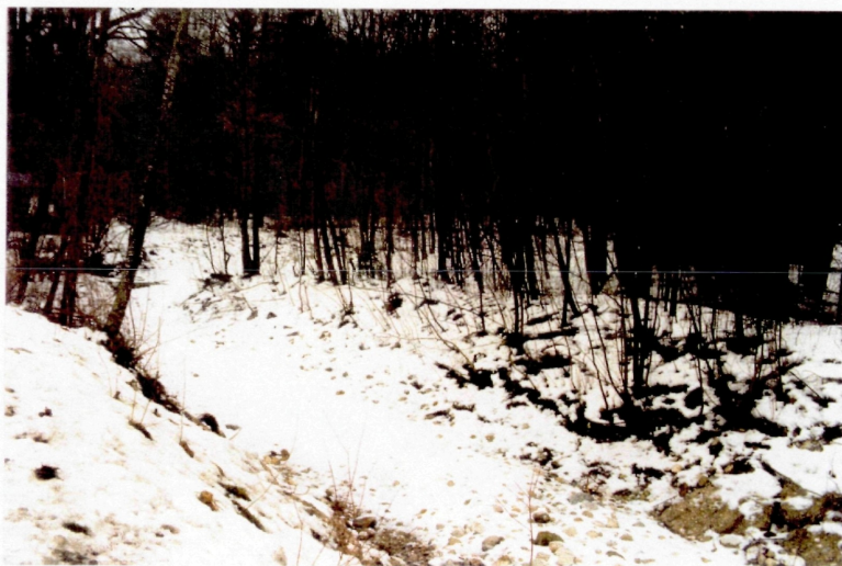
Abb. 83: Unterhalb dieser weiteren Ausleitungsstelle ist der Mühlbach trocken gefallen. Lediglich bei Hochwasser wird dieses Bachbett dotiert
