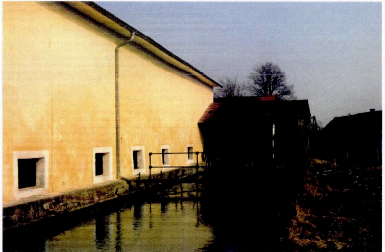
Abb. 141: Einlaufbauwerk der Hafeldmühle
