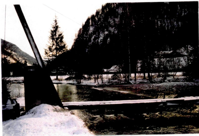
Abb. 14: Blick auf das Rabenauerwehr
