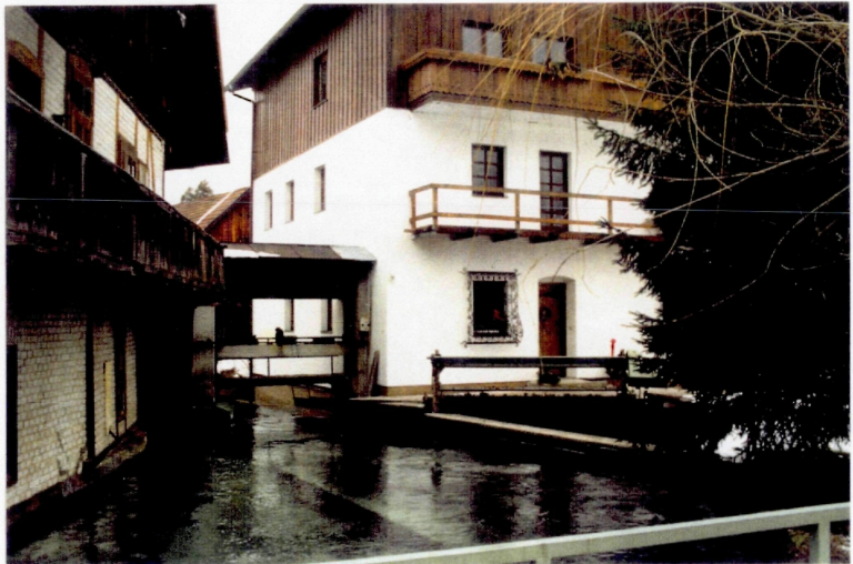
Abb. 37: Rechenanlage und Einlauf in das Krafthaus des E-Werkes II in Grünau
