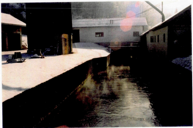
Abb. 45: Kraftwerksauslauf und Unterwasserkanal (insgesamt 900 m lang) des Kraftwerkes Lippenannerl
