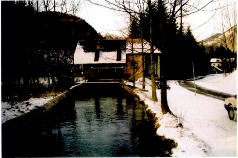
Abb. 19: Der Mühlbach und das erneuerte Krafthaus des E-Werkes Rabenbrunn
