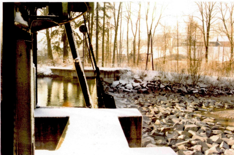
Abb. 85: Blick über das Sperlwehr
