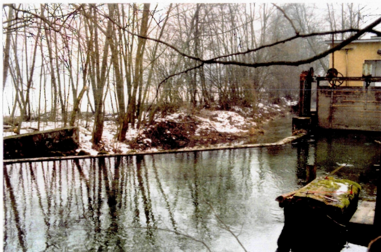
Abb. 115: Blick über die betonierte Wehranlage zum Einziehen des Wassers aus dem Mühlbach in die Grubmühle
