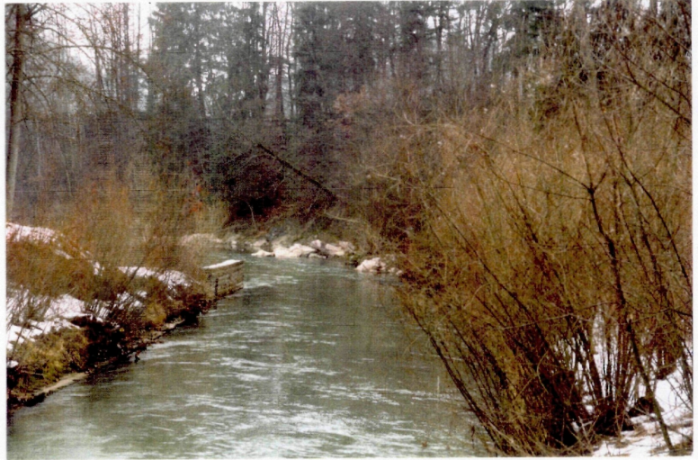
Abb. 103: Unterwasserkanal der Schwarzmühle und die durch Steinbuhnen gesicherten Prallhangbereiche am rechten Ufer
