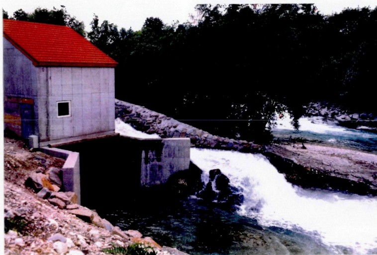
Abb. 139: Das Krafthaus und der Unterwasserkanal mit Blick auf die Hafeldergefällstufe
