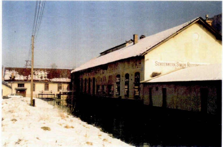
Abb. 56: Einlauf des Mühlbaches in die Wasserkraftanlage Redtenbacher
