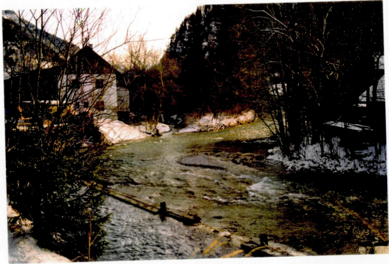
Abb. 18: Blick alaufwärts zur Rabenauersäge
