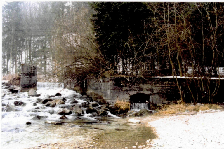
Abb. 121: Überreste der Ausleitungsstelle
