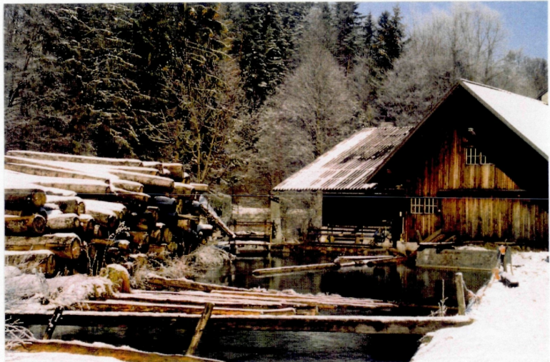
Abb. 51: Blick auf das Krafthaus und die Rechenanlage der Sagbauernsäge
