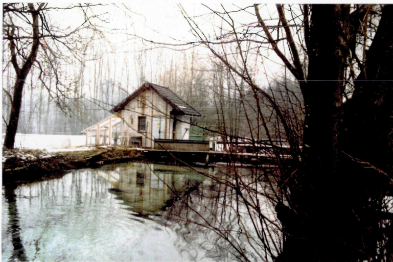
Abb. 113: Einlauf- und Rechenbauwerk der Grubmühle
