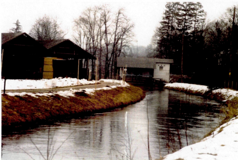
Abb. 84: Das Krafthaus und die Rechenanlage der Lahnsäge
