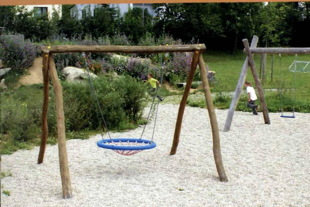
Für Sitzflächen und konstruktive Teile wurde gehobeltes Schnittholz verwendet. Die Spielgeräte bestehen aus Rundholz, das im Abtastverfahren entrindet wurde und somit die natürliche Form und Haptik des Baumes erhält.
