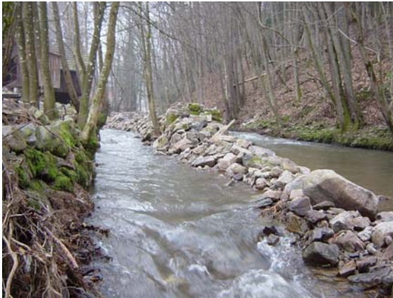
Abb. 26 (links): Auslauf des Mühlgrabens bei der Achleithnermühle (P18), rechts im Bild die Restwasserstrecke, dazwischen die provisorische Trennmauer (die „ursprüngliche“ Mauer wurde beim Hochwasser 2002 zerstört)
