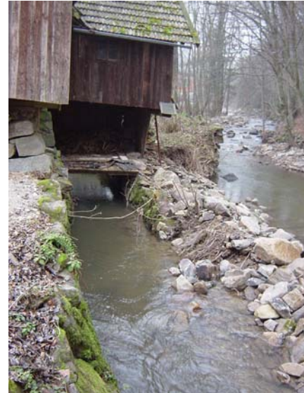
Abb. 26 (links): Auslauf des Mühlgrabens bei der Achleithnermühle (P18), rechts im Bild die Restwasserstrecke, dazwischen die provisorische Trennmauer (die „ursprüngliche“ Mauer wurde beim Hochwasser 2002 zerstört)
