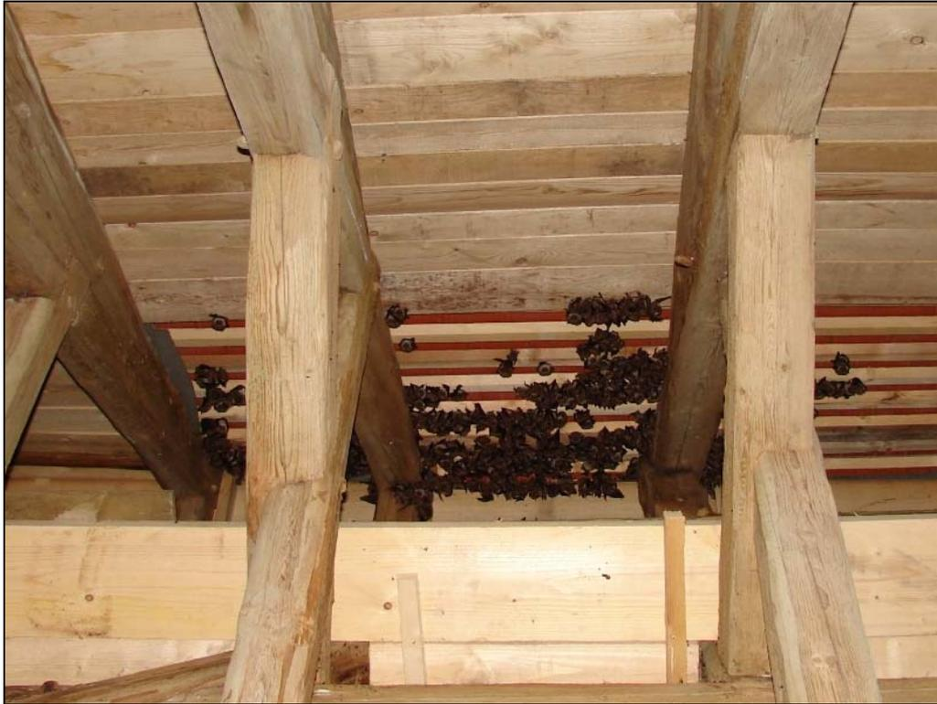
**Abb. 12** Der alte Hangplatz wurde mittels Aussparung des neuen Kaltdaches in diesem Bereich nahezu unverändert für die Tiere erhalten.
