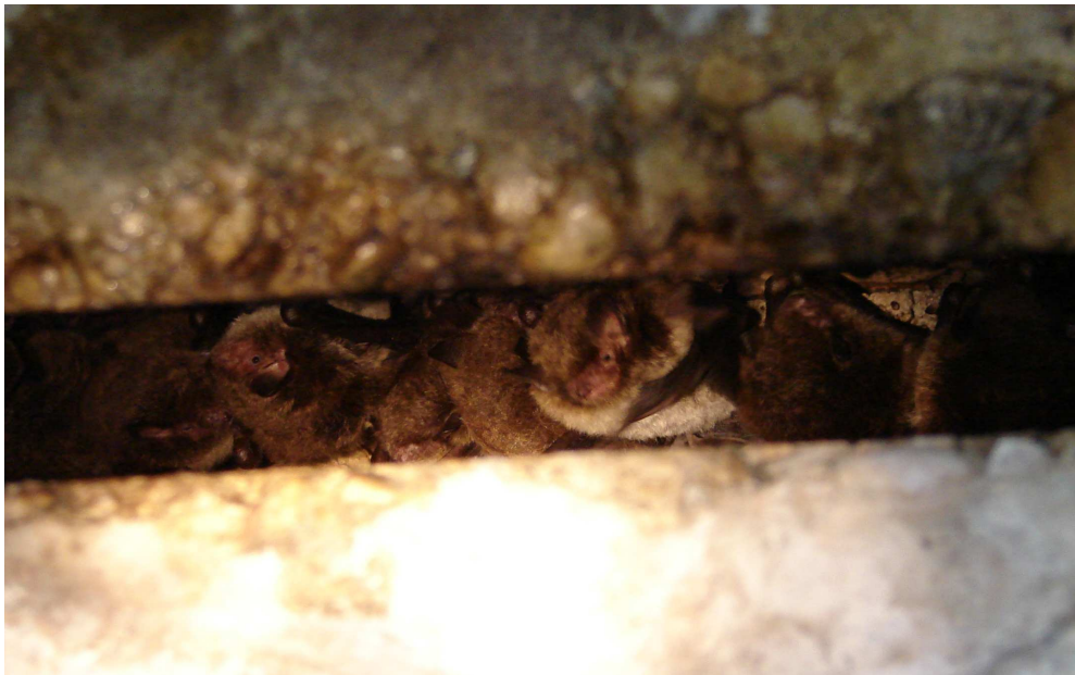
Abb. 12 In einem Brückenspalt in Mitterkirchen im Machland wurde heuer eine Kolonie von Wasserfledermäusen ( Myotis daubentonii ) entdeckt. (Foto: S. PYSARCZUK)
