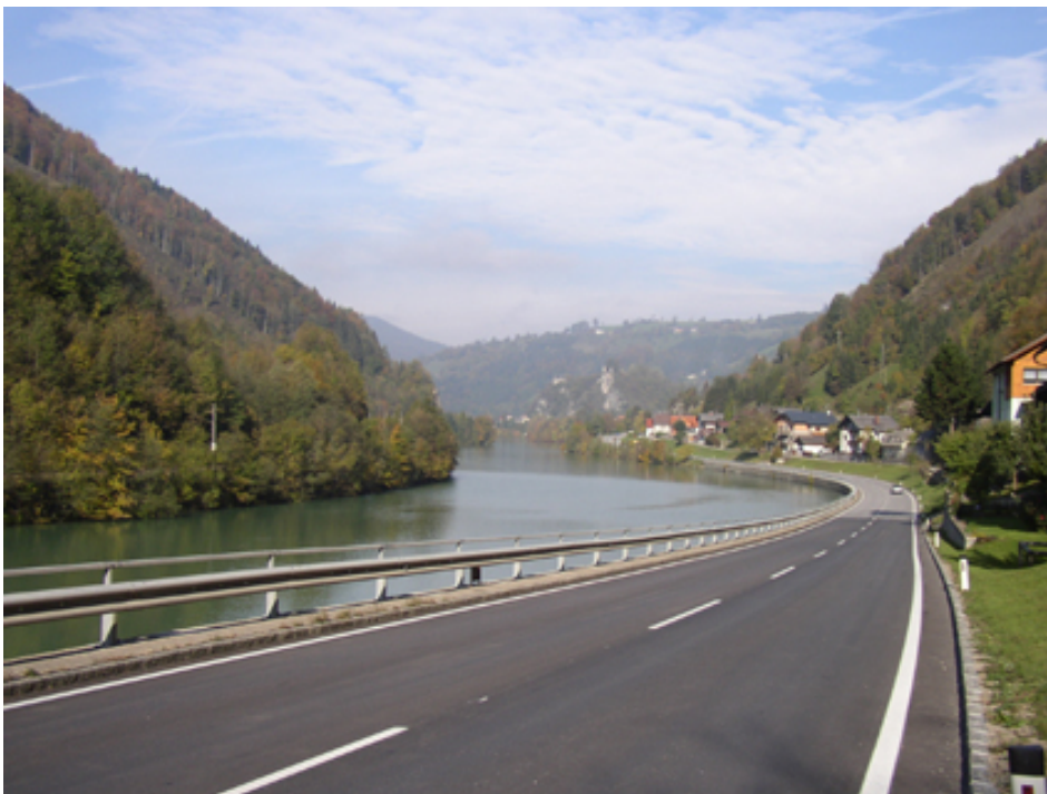
Foto 10008: Ennsfluss mit angrenzender Straße, Nähe Einmündung Trattenbach
