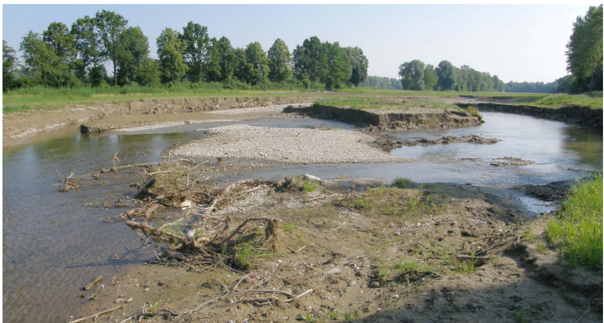
Gurtenbachmündung in den Inn, 25.6.2010: Neues, durch Revitalisierungsprojekt geschaffenes Bruthabitat für den Flussregenpfeifer; Foto: K. Billinger;
