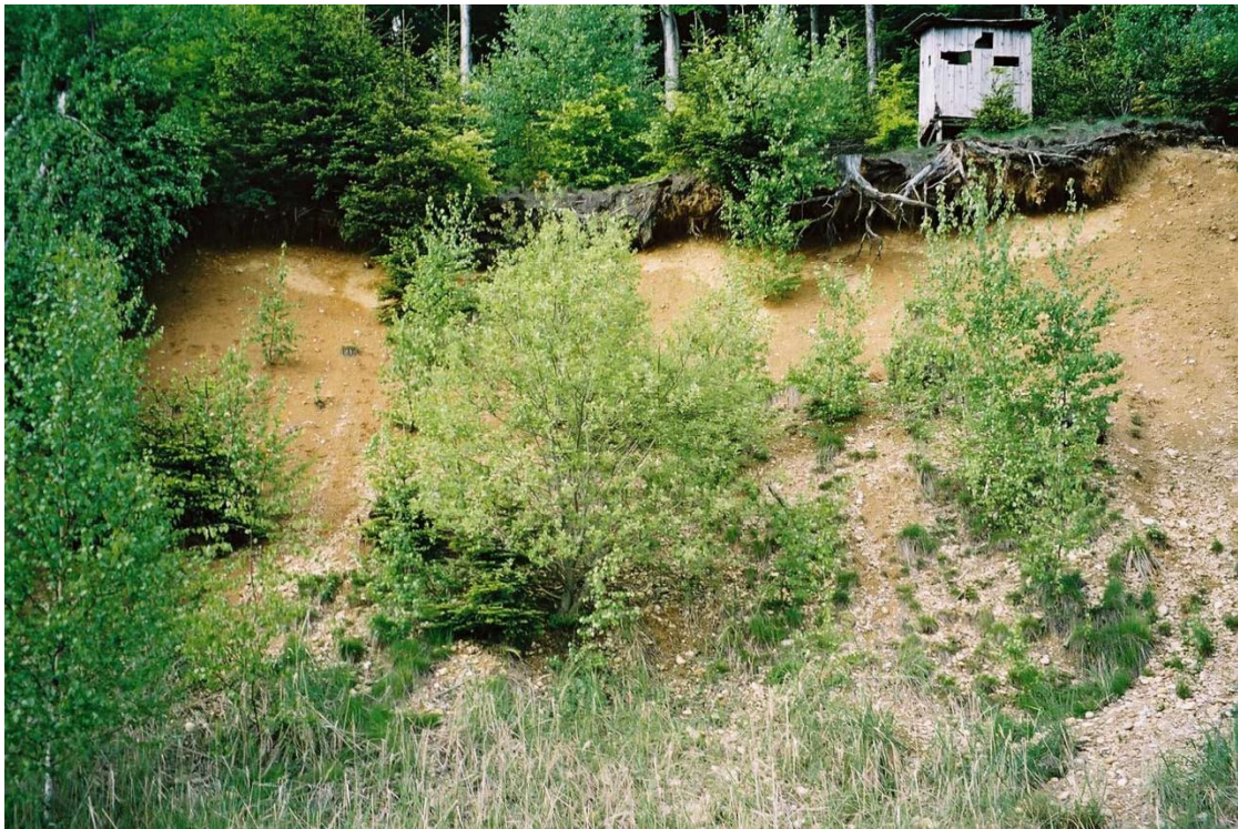
Abb. 6: Offene Böschung am Oberrand des ehemaligen Bergbaugeländes.(Foto: T. Anzböck)
