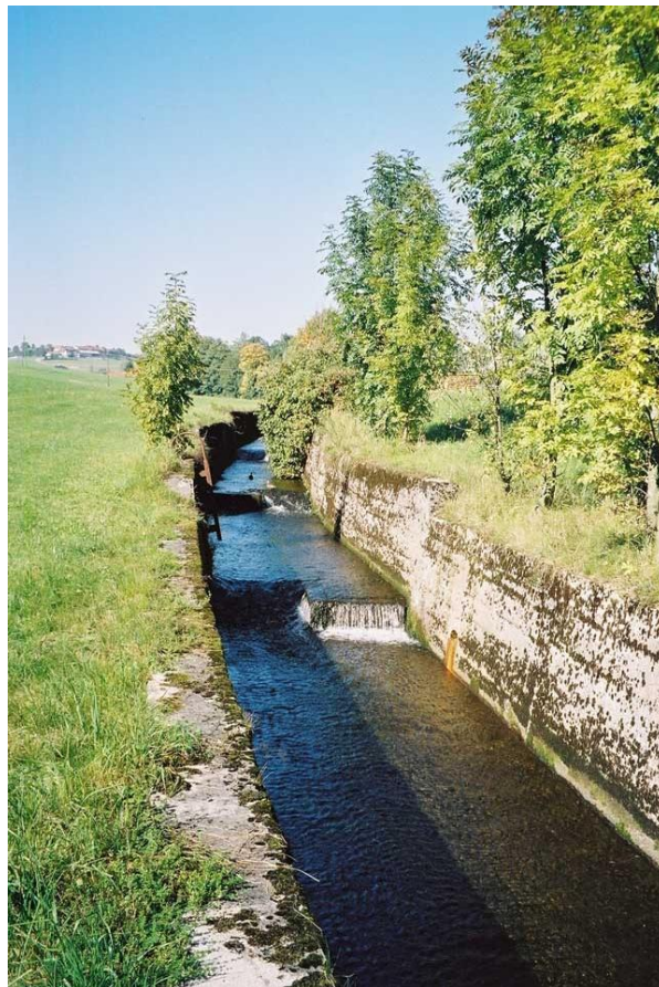
Abb. 10: Stark verbauter Bachabschnitt W Ortsgebiet. (Foto: T. Anzböck)
