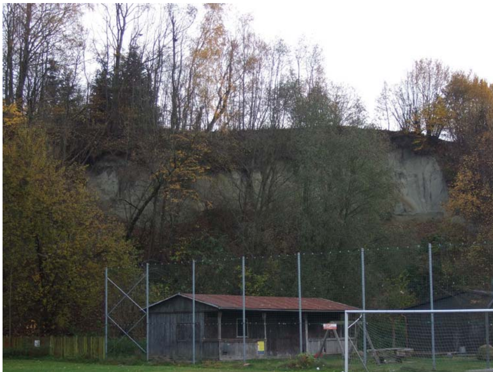
Abb. 10: Hohe Böschung mit Schlier-Steilwand im Süden von Andorf (Foto: FREIRAUMPLANUNG STÖCKL)
