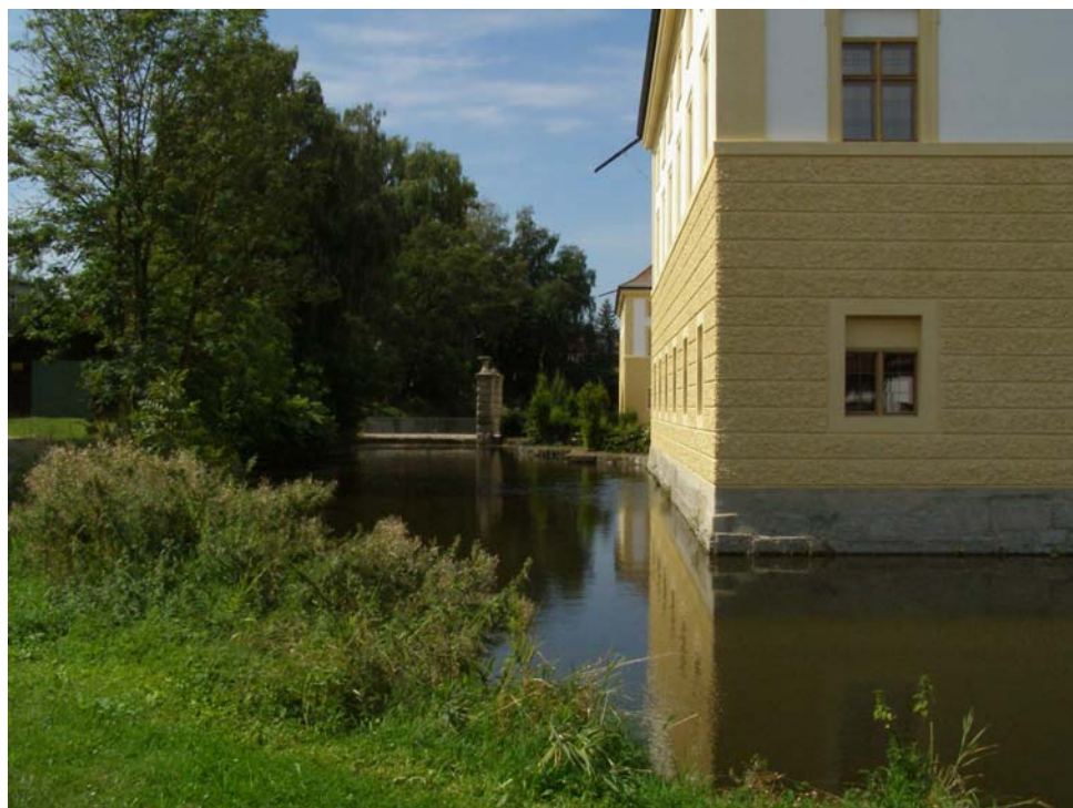
Abb. 3: Wassergraben beim Schloß Auroldmünster (Foto: AVL)
